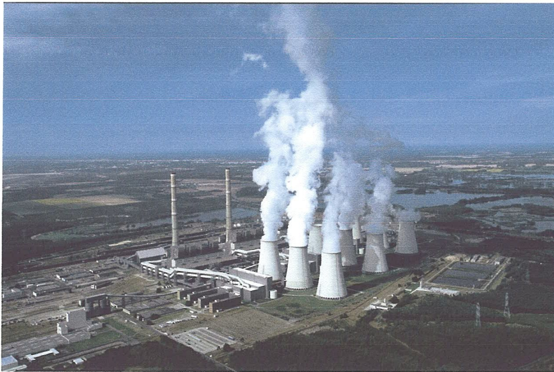
Fig I.3 : Centrale Thermique en Allemagne
