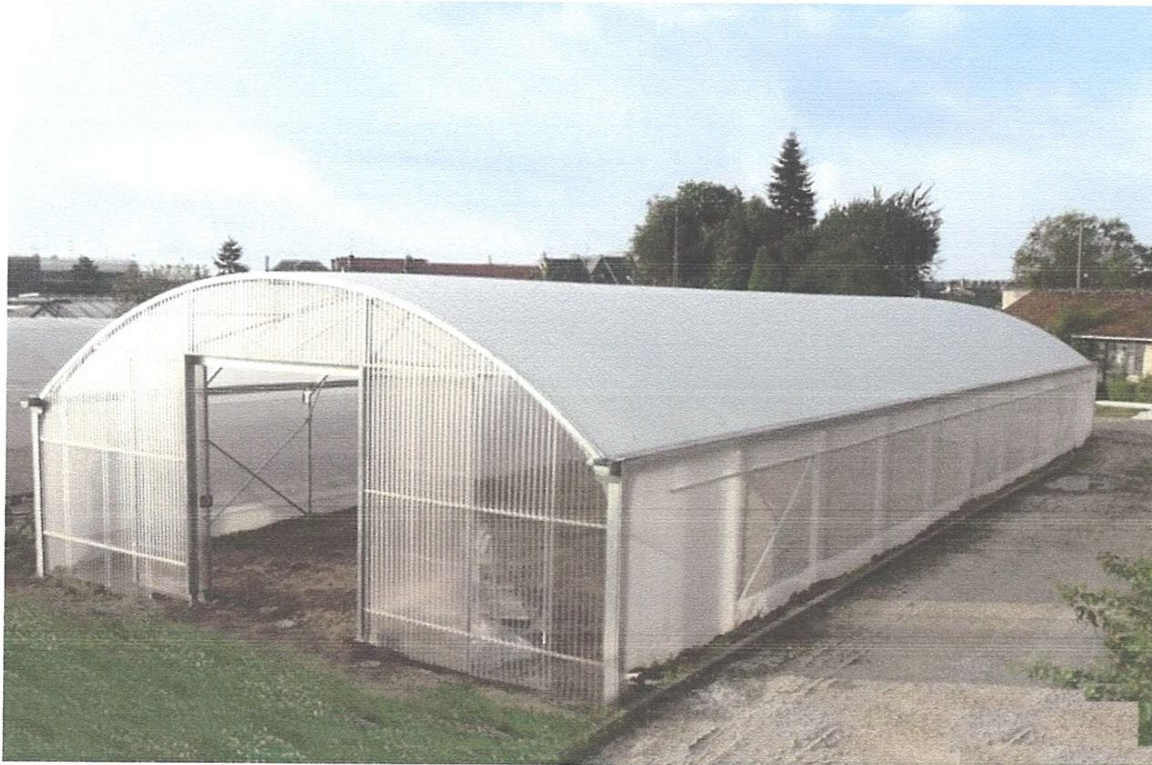
Figure IV.1 : Une serre agricole.
