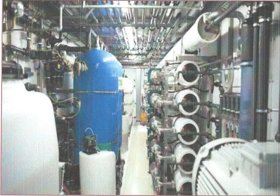
**Figure II.8 :** Installation d'osmose inverse pour le traitement des eaux
