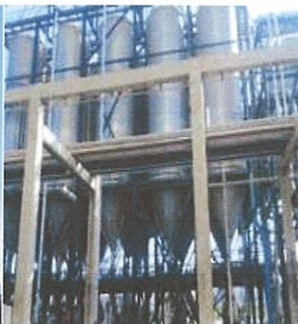
Figure A.13: Silos de stockage des granulés.
