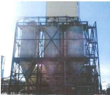
Figure A.12 : Silos de stockage de la poudre.
