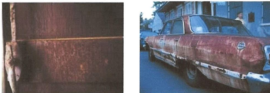
Figure III-1 : Corrosion généralisée : Exemple d'une porte et d'un véhicule corrodés
