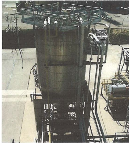
Figure II.12 : La chambre de flash alternative.
