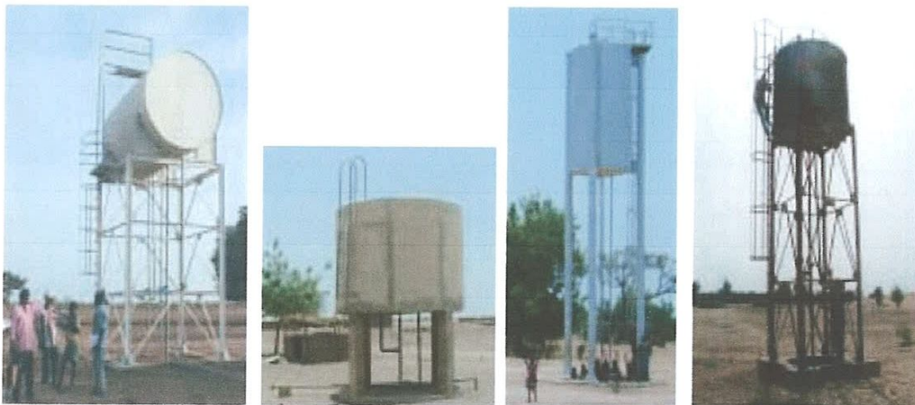
Fig. III.2 : Illustration de la variété des réservoirs surélevés en termes de forme, taille et hauteur [7].
