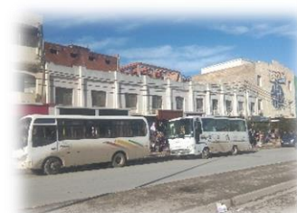
Figure 85: Arrêt de bus, Boulevard du volontariat, Guelma. Source : cliché par l'auteur, 2019.
