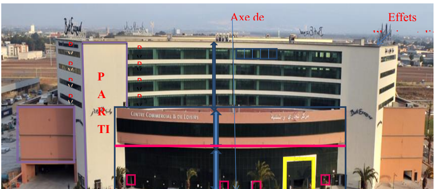
Figure 95: Façade du centre de commerce et de loisirs BAB AZZOUAR. Source : Mémoire de master. BEN ALI Selma. Centre de commerce et de loisirs. 2017. Département d'architecture, Bejaia, Algérie. P117.
