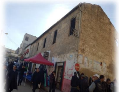
Figure 80: Habitat colonial + commerce au RDC, Guelma. Source : cliché par l'auteur, 2019.
