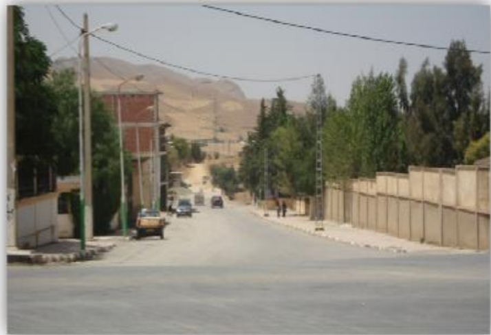
Axe principal à partir de la RN 16 vers la gare routière →
