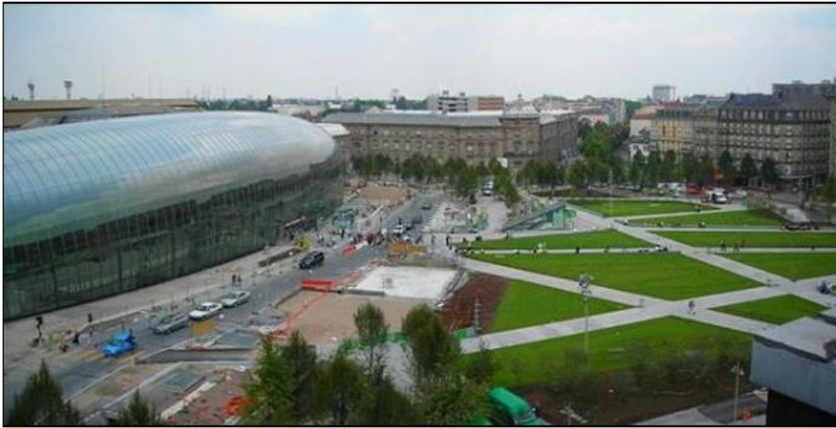
Figure 18 : Vue sur la plage de la gare
