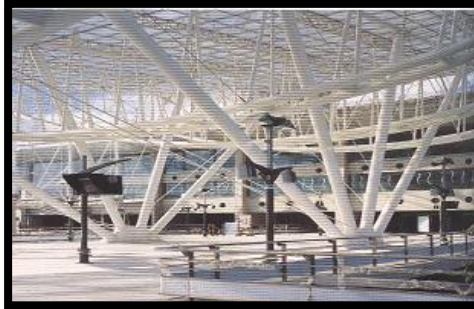
figure 04 : vue sur la structure de roissy
