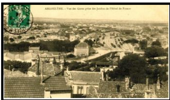
Figure 06 : Vue panoramique de la « gare d'Orléans » à Angoulême (site de la gare actuelle) et du faisceau ferroviaire à la fin du XIXe siècle. (Source: Archives Municipales d'Angoulême)
