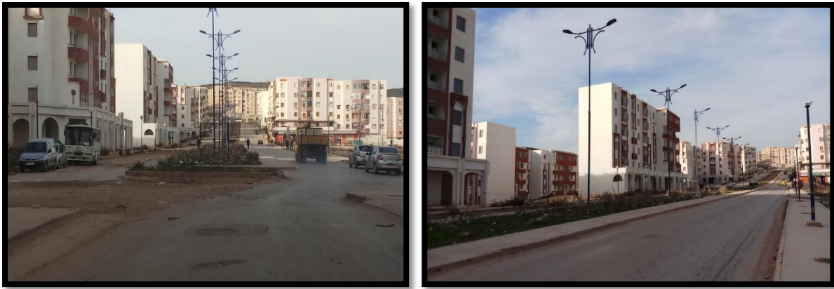
Figure 23 : la nouvelle extension (le pos sud) de la ville de Guelma
