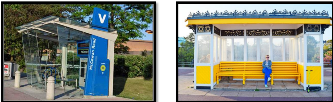
Figure 30 : des arrêts de bus aménagés Source : Google image
