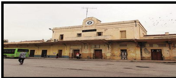
Figure 26 : la gare ferroviaire de la ville de Guelma Source : Google image
