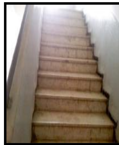
Fig. N° 26 « vue sur cage d'escalier. » Source « traitement auteur 2018 »
