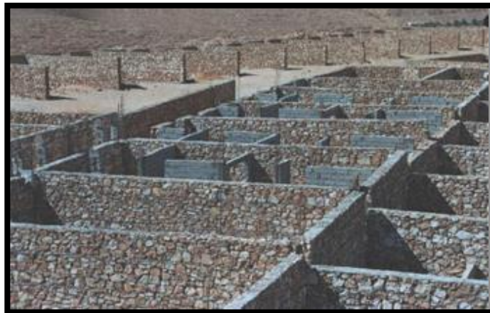
Fig. N° 18 « le chantier » Source ( http://tafilelt.com/site/ )
