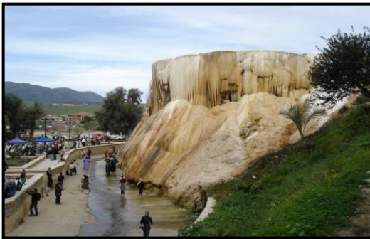
Figure 56 : Réalisation d'une esplanade à Hammam Debagh Source : liberte-algerie.com
