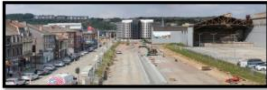
Figure 29 : Construction de nouvelle voirie –chantier
