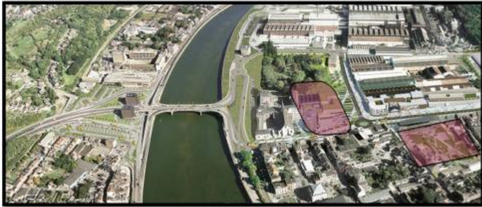
Figure 22 : Emplacement de nouveaux équipements
