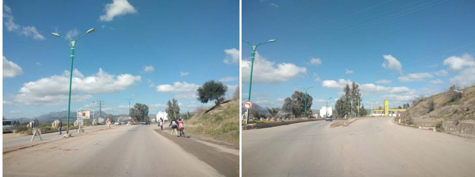
Figure 61 : Entrée Nord Guelma
