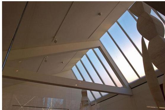
**Figure 1.04:** Exemple de la tabatière: L'éclairage zénithal de l'atelier Brancusi
