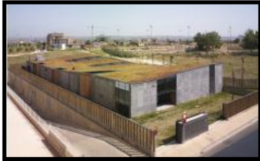
Figure 35: Exemple de toiture végétalisée et de mur masse, Oliver Kindergarten Source : ( https://www.arc.ulaval.ca/files/arc/JacquesChristelle_EPH2013.pdf )
