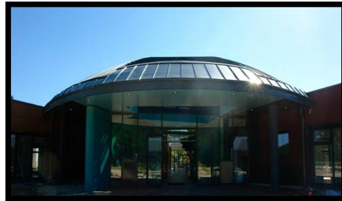
Figure 96 : l'entrée principale du centre source : http://docplayer.fr/storage/61/45885875/1546733259/HyHpxYy_WJXy7QwlJJOWDA/45885875.pdf
