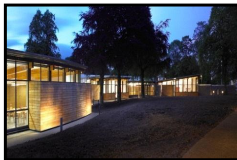
Figure 174: l'utilisation d'éclairage artificiel doux, source : Google image.com
