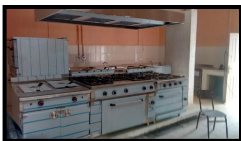
Figure 216 : la cuisine, bloc -C-
