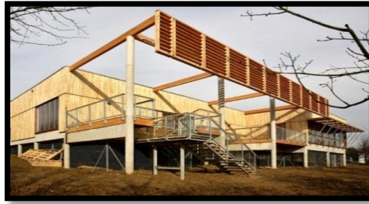
Figure 85 : ossature bois et bardage en châtaignier, source : http://www.claudeleguillard.com/reportages/kiethon/kiethon.html
