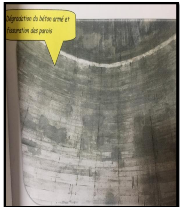
Figure 9 : L'état intérieur du réservoir 300M 3
