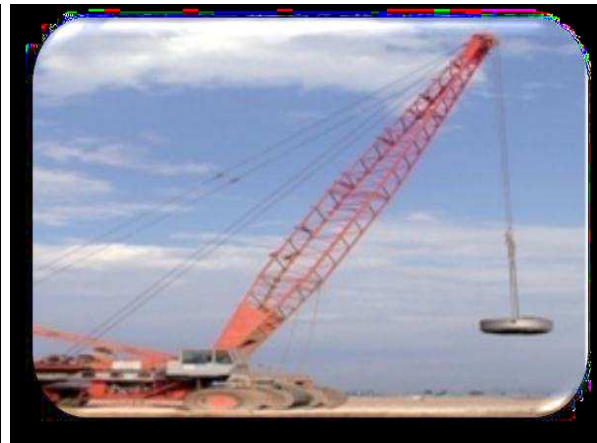
Figure 3.2 : Compactage dynamique.
