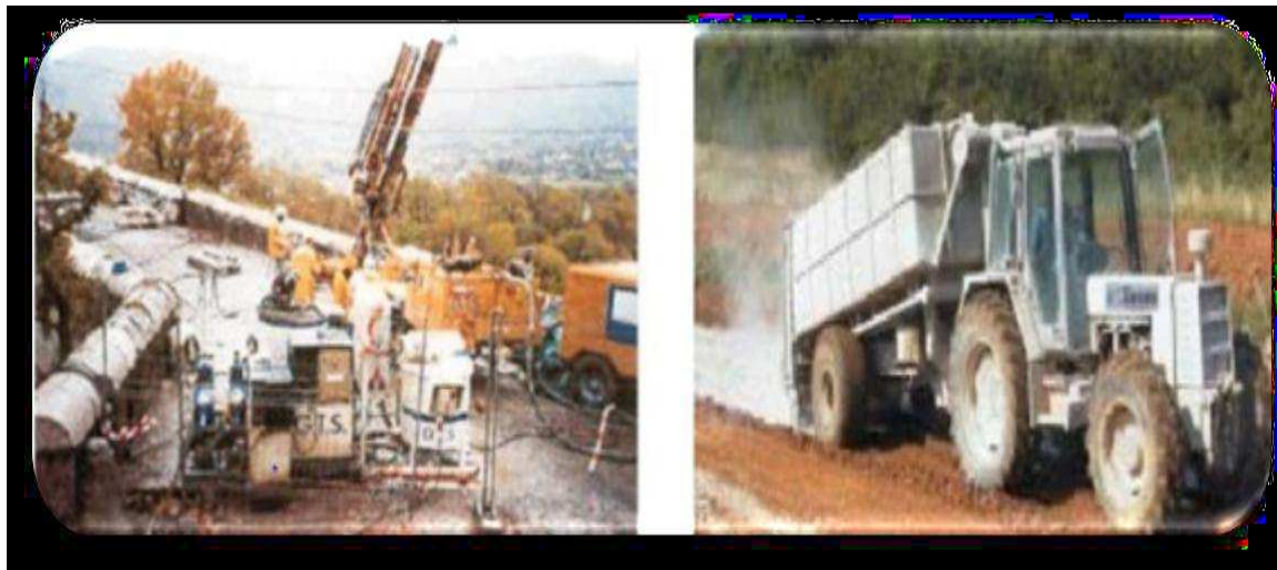
Figure 3. 4 : Traitement chimique à la chaux et au ciment.
