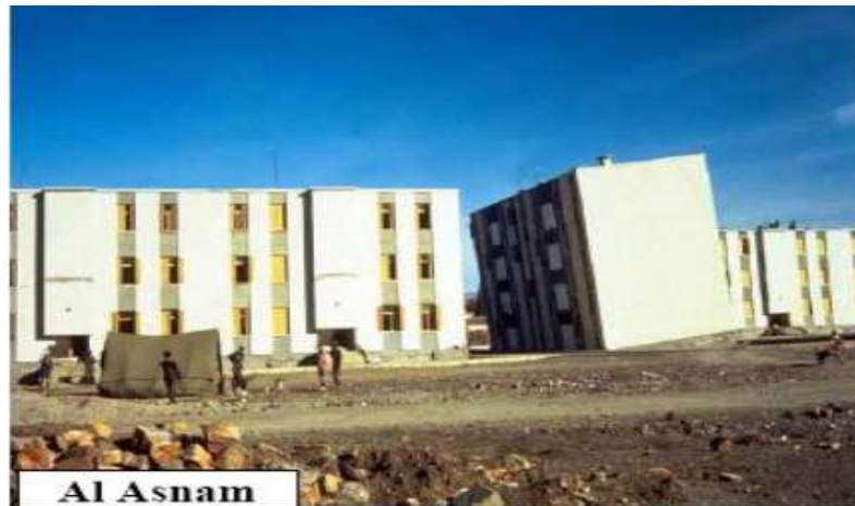
Figure 1. 11 : Montre des bâtiments renversés à El Asnam en 1980 Par la liquéfaction.
