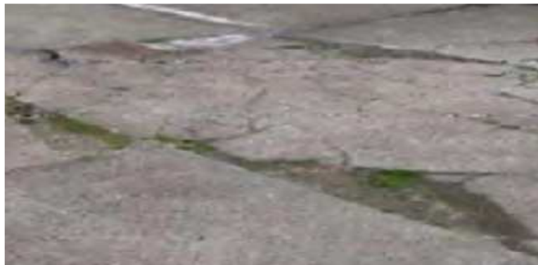
Figure 1.13 : Type de sol sensible au gel.
