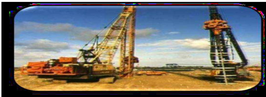
Figure 3. 3 : Compactage par vitro-sonde.
