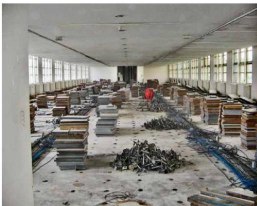
Figure II.3: Opération de tri durant une déconstruction sélective [3].
