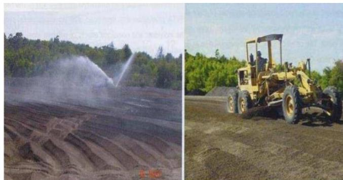
**Figure II.13:** Procédé ACERITA, vieillissement naturel du laitier (Brésil) [66].
