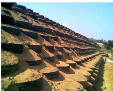
**Figure IV.2 :** Chantier expérimental Pneusol à Bou-Smail (Algérie).
