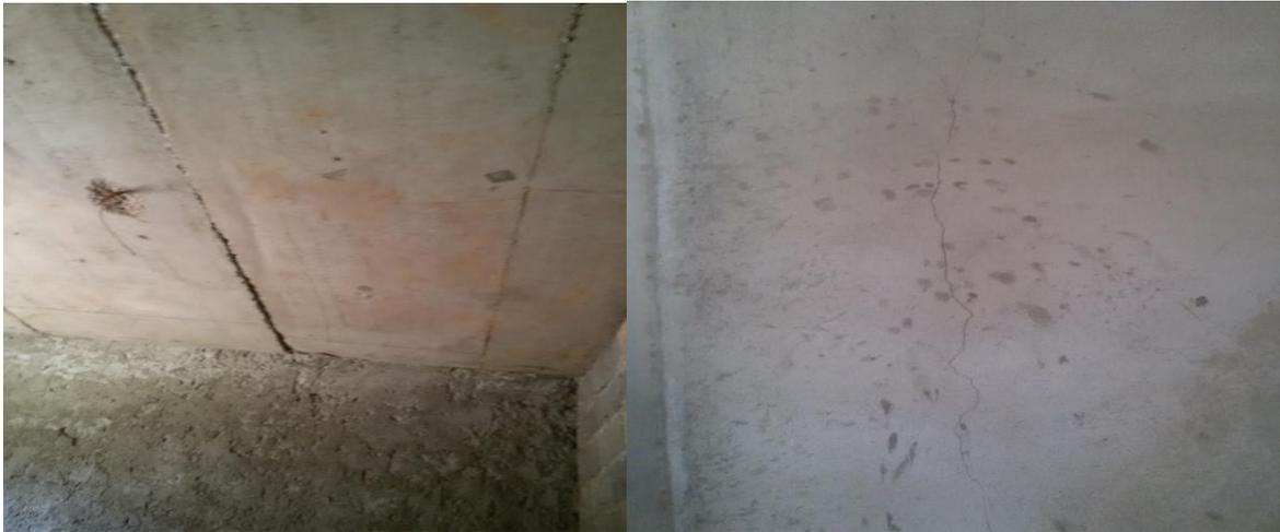
Figure 4.2 Fissurations du béton
