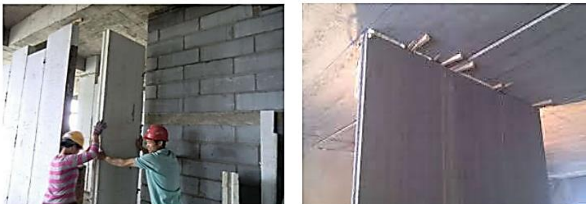
Figure I.12 : Quelques applications de béton polymère pour l'isolation [4]
