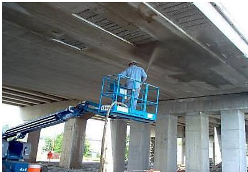
Figure I.4: Réparation d'un pont grâce à l'utilisation du béton projeté [2]
