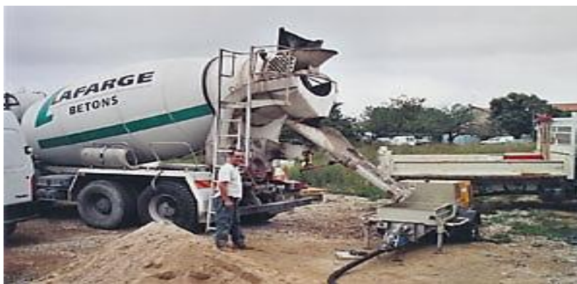
Figure I.1 : camion toupie alimentant une pompe à béton [2]
