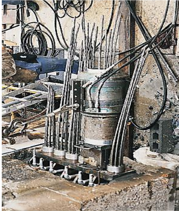
Figure I.3 : Mécanisme de post-tension [2]
