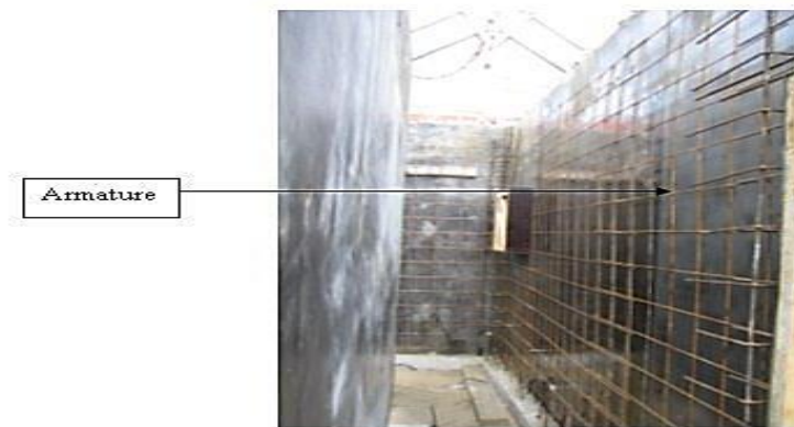
Figure I.2: Armatures à béton armé dans un coffrage [2]
