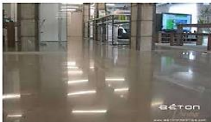
Figure I.9: Plancher en béton polymère [4]
