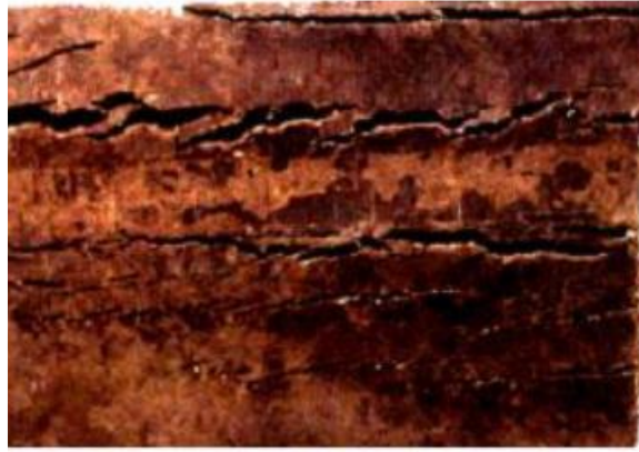
Figure I.5 : Fissures de corrosion sous contrainte(CSC) [Habc, 13].
