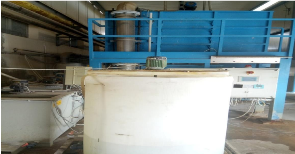
Figure II.2: Photo de décanteur, du bassin de mélange (floculant+ l'eau) et du bassin de mélange (le coagulant + l'eau) installé à la station de traitement d'eau.
