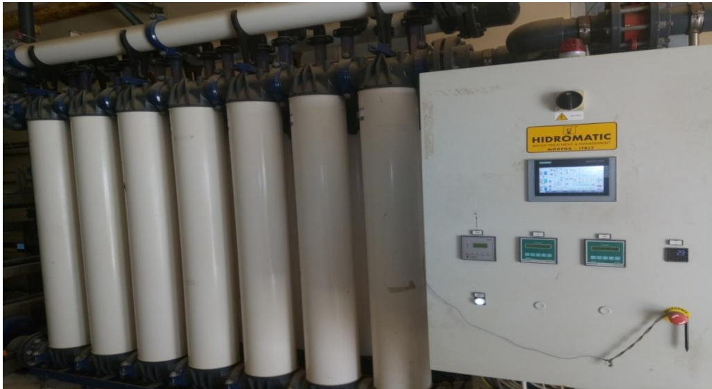
Figure II.4: Photo de la membrane Ultrafiltration installée à la station de traitement à l'usine d'AMOR BEN AMOR.
