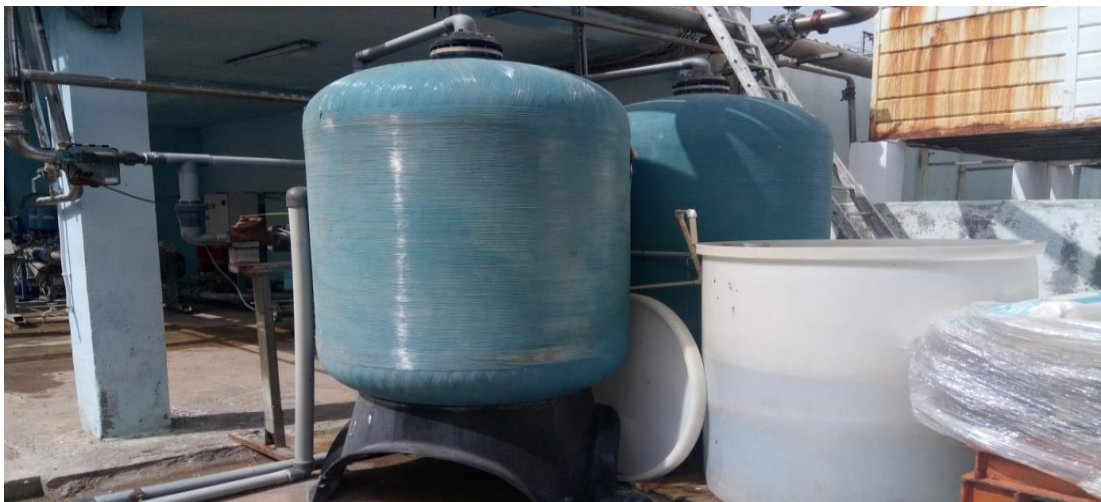
Figure II.7: Photo de l'adoucisseur installé à la station de traitement à l'usine d'AMOR BEN AMOR.
