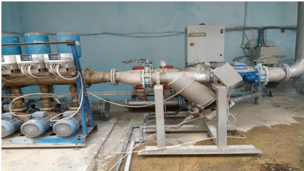
Figure II.1: Photo de l'autonettoyant utilisé à la station de traitement d'eau.
