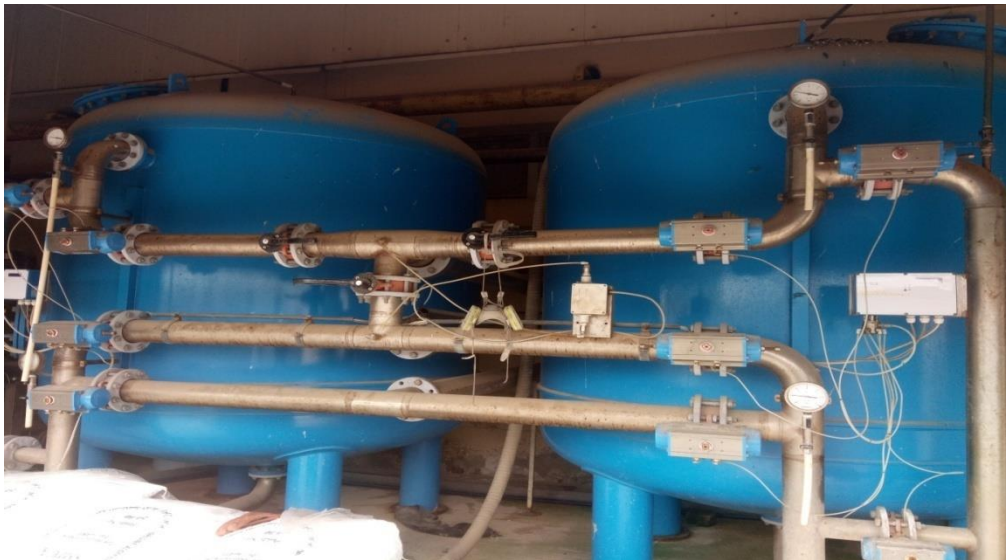
Figure II.3 : Photo de filtres à sable installés à la station de traitement d'eau à l'usine d'AMOR BEN AMOR.
