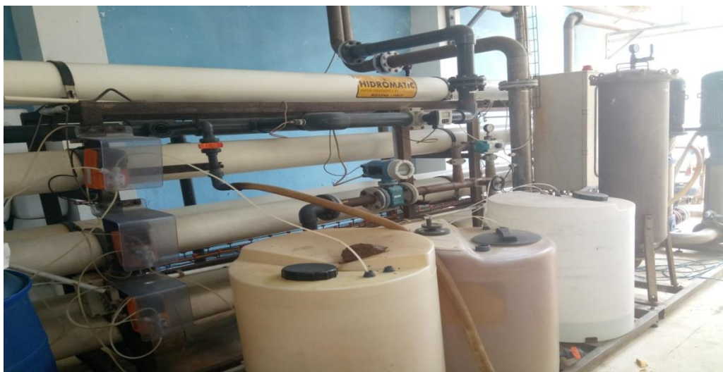
Figure II.6: Photo de la membrane de l'osmose inverse installée à la station de traitement à l'usine d'AMOR BEN AMOR.
