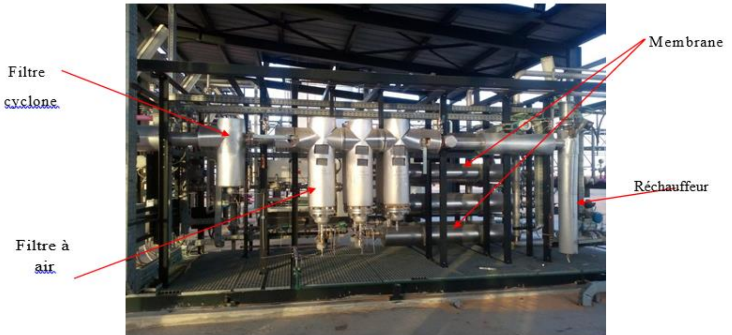
Figure A.2. Unité de production d'azote sur site
