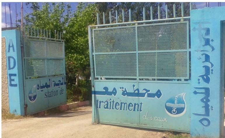
Photo II-3 : Station de traitement des eaux du barrage de Hammam Debagh.
