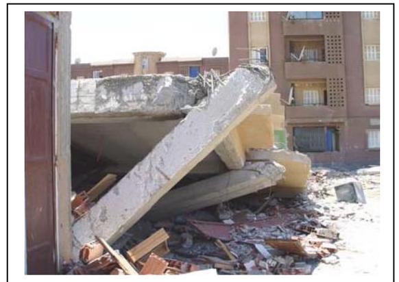
**Figure 3.12:** Comportement aléatoire des bâtiments à ossature en portiques (poteaux + poutres) et remplissage en maçonnerie (Séisme de Boumerdès, Algérie 2003) [1].
