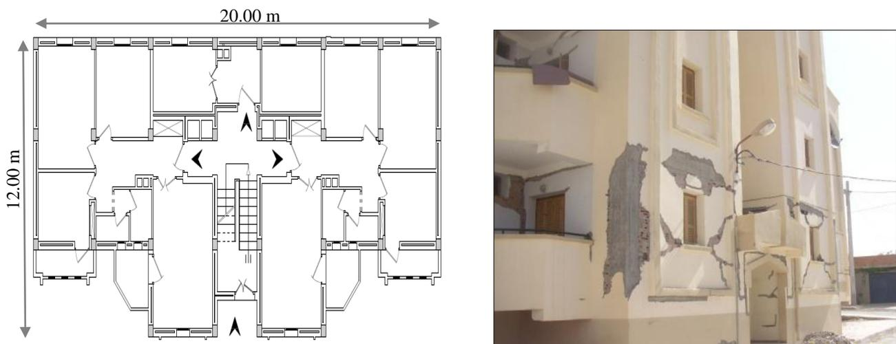
Figure 5.20: Vue en plan et façade du bâtiment B1.
