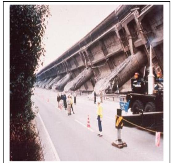
**Figure 3.10.** Effondrement dans la structure isostatique (séisme de Kobé, Japon, 1995)
