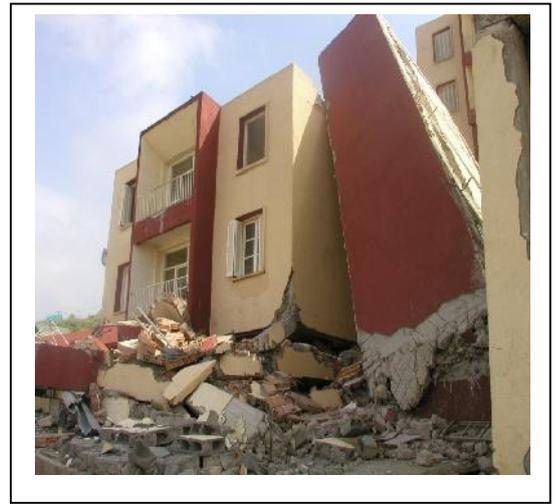
**Figure 3.11:** Largeur de joint insuffisante (Séisme de Boumerdès, Algérie 2003) [1].
