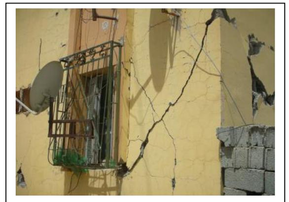
**Figure 3.13:** Comportement aléatoire des bâtiments à ossature en portiques (poteaux + poutres) et remplissage en maçonnerie (Séisme de Beni Ilmene, M'sila 2010) [2].
