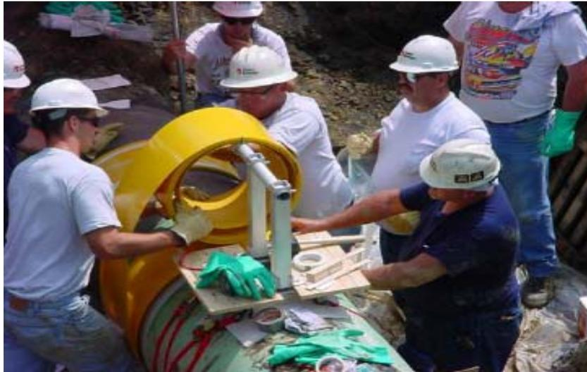
**Figure I.19.** Dispositif de Clock Spring pour la réparation de canalisation.
