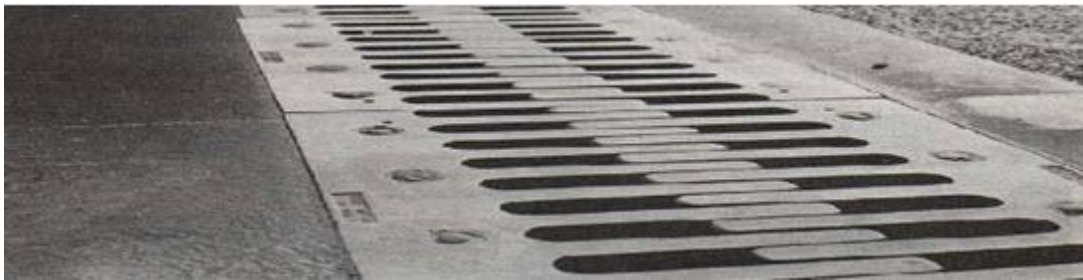
Figure 57. Joint de chaussée.
