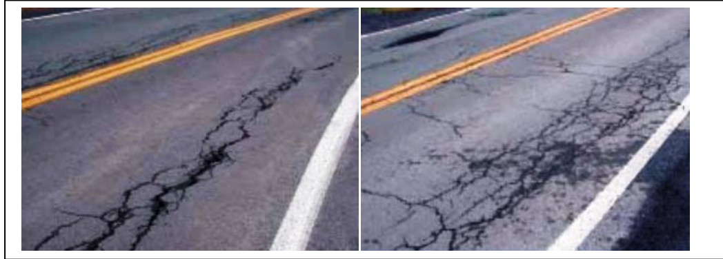
Fig.III.8 :Fissure en piste de roues
