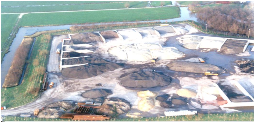
Figure VI.10. Le stockage des vieux enrobés nécessite de l'espace et des installations supplémentaires
