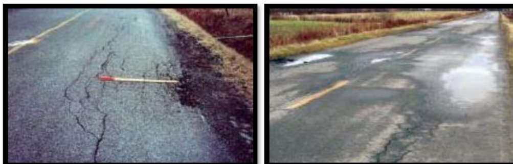
Fig.III.17 : affaissement
