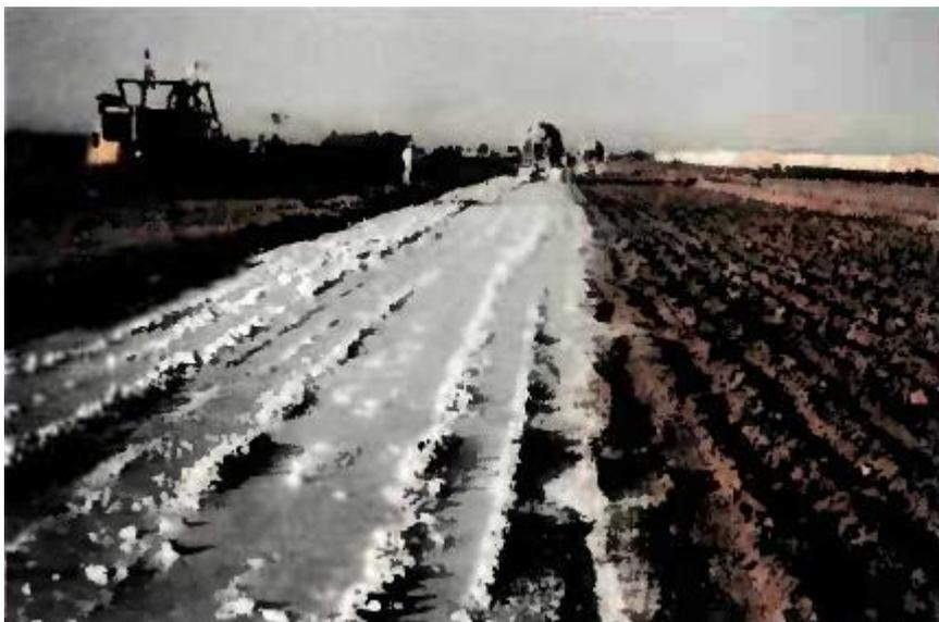
*Figure 24 : Epandage de lait de chaux pour traitement d'un sol argileux*
