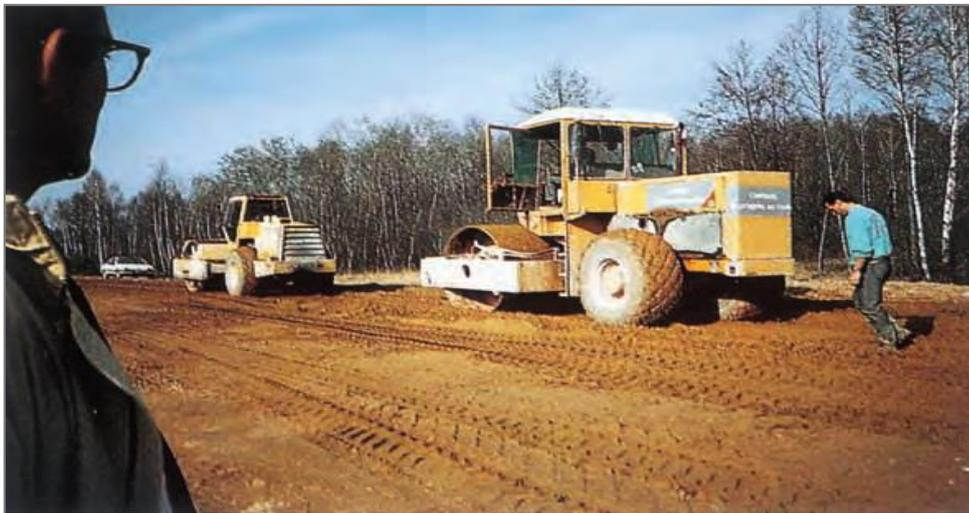
*Figure 35 : Un compacteur vibrant monocylindre lisse*
