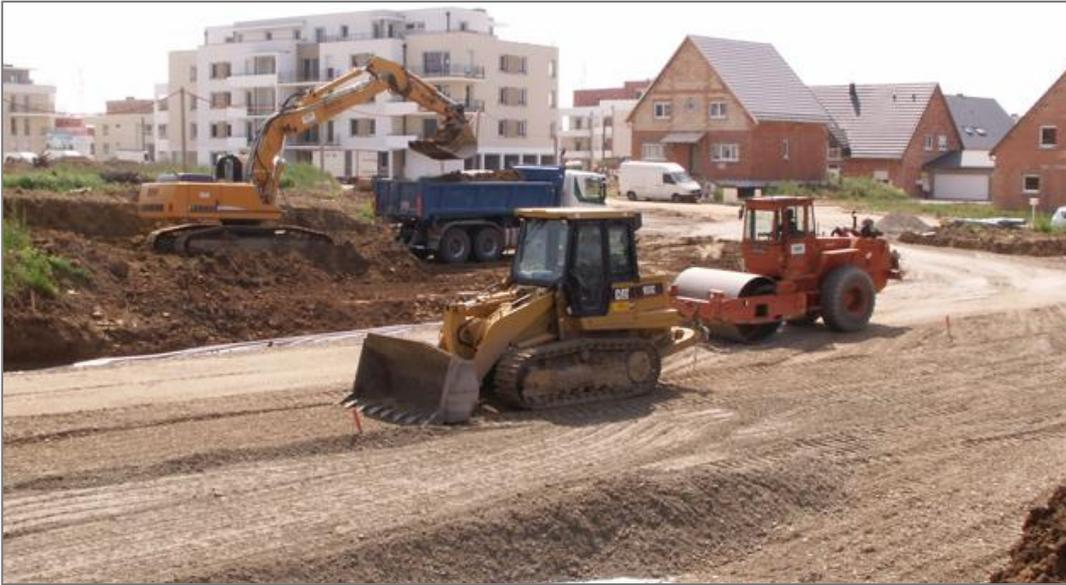
*Figure 19 : Réalisation des travaux de terrassement*
