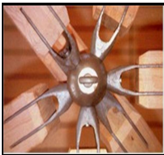
Figure 2-12 : assemblages par organes métalliques
