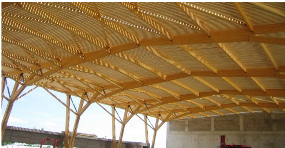
Figure 1-4: photo de l'assemblage poteaux poutre.
