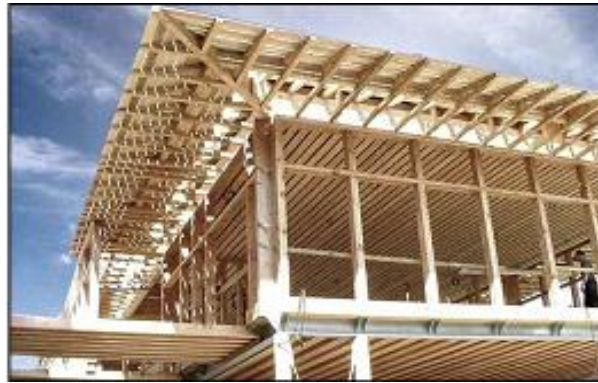
Figure 3-16 : Maisons à ossature bois
