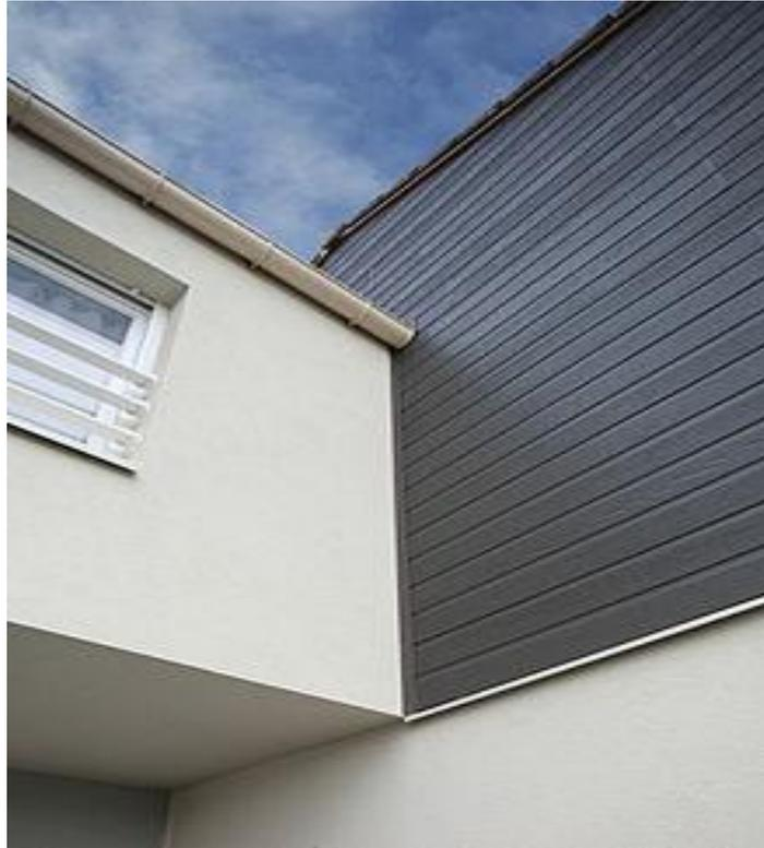
**Figure 7 :** Réalisation en ITE panachant une finition en enduit mince sur isolant et une finition en bardage ventilé.
