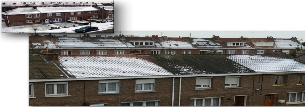
**Figure 8 :** En climat tempéré, la première source de déperdition thermique des maisons est la toiture (jusqu'à 30 %, voire plus). La fonte de la neige sur les toitures montre ici les défauts d'isolation de certaines maisons, se traduisant par un gaspillage d'énergie et des dépenses accrues, ainsi que des impacts sur l'environnement. En l'absence de neige, une thermographie rend visible ces pertes de chaleur.
