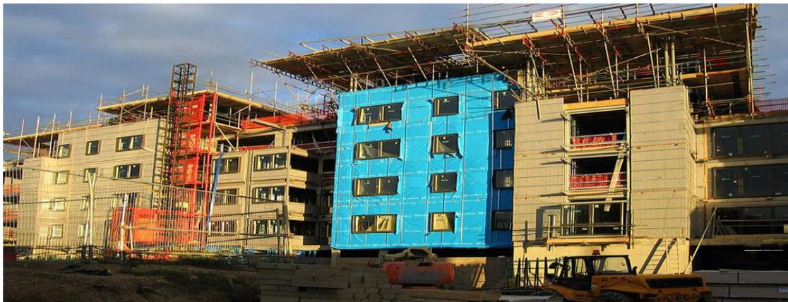
**Figure 2 :** Isolation thermique dans le bâtiment. Ici les bâtiments sont isolés par l'extérieur afin de limiter les ponts thermiques.
