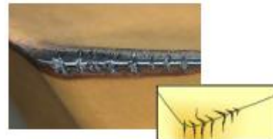
(b) Usure par fissuration thermique
