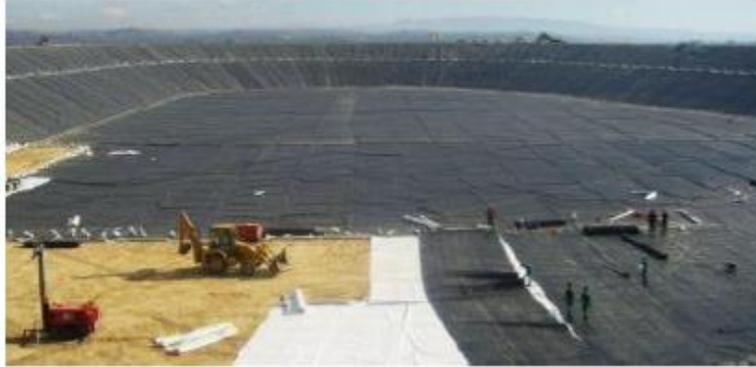
**Figure 3.23** Mise des géogrilles au-dessous des drains
