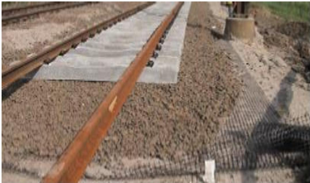
**Figure 3.22** Installation des géogrilles au niveau des traverses, avant le levage et le bourrage du ballast
