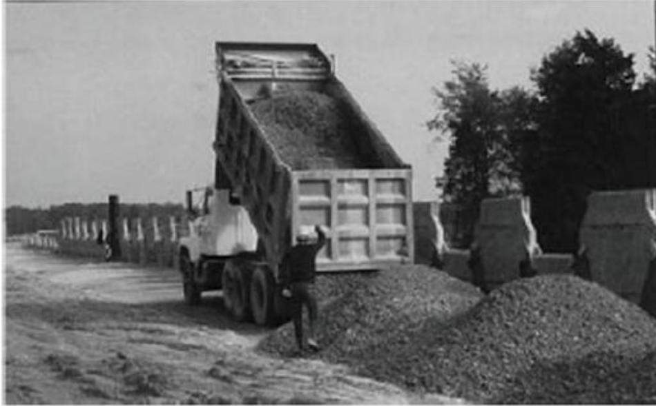
**Figure 3.8** Transport du matériau du remblai pour la première couche
