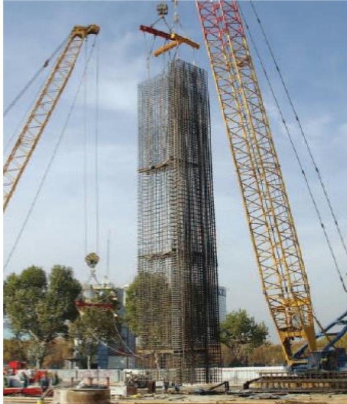
**Figure 1.22** Mise en place d'une cage d'armature
