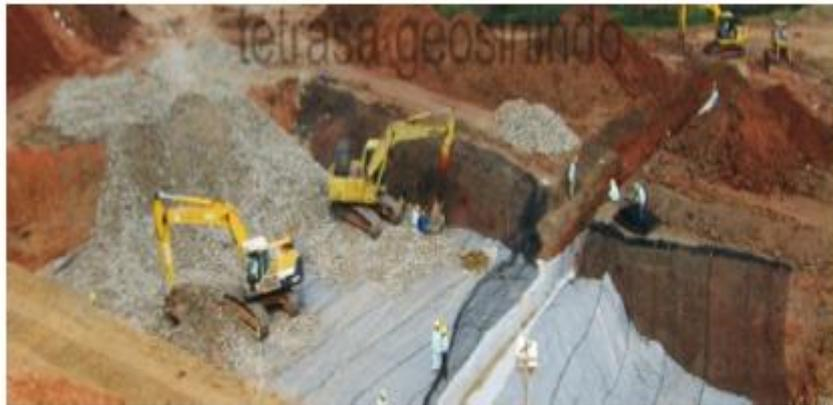
**Figure 3.24** Séparation de matériaux de remblais
