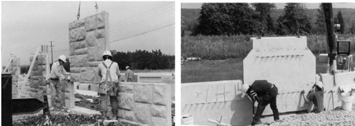
**Figure 3.7.**Mise en place des écailles
