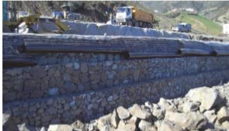
**Figure 3.26** Mur de protection contre le glissement
