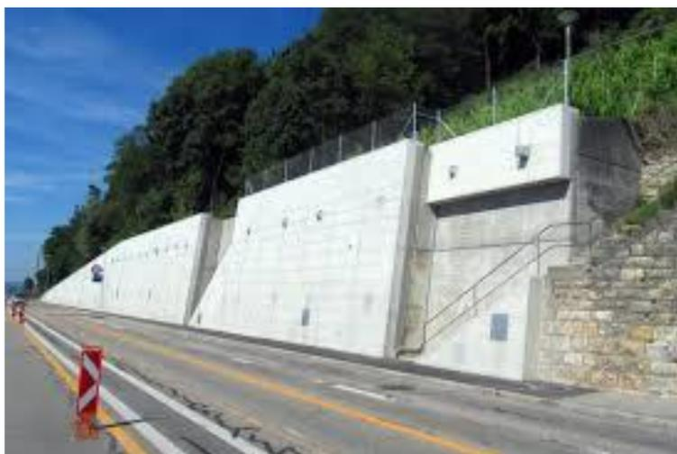
Figure 1.2 Exemple réel de soutènement
