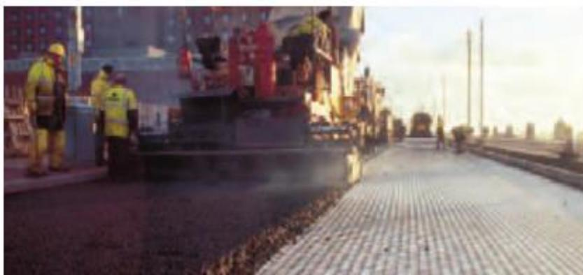
**Figure 3.25.** L'enrobé est mise en œuvre directement sur la géogridle
