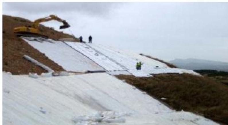
**Figure 3.27** Mise en place de la géogrille de retenue des terres
