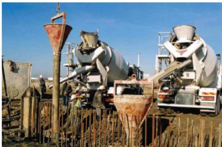
**Figure 1.23** Bétonnage d'un panneau par deux camion
