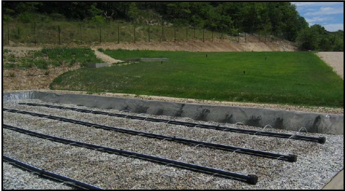
Figure III – 3 : Filtre à écoulement verticale avant et après plantation de roseaux [1].
