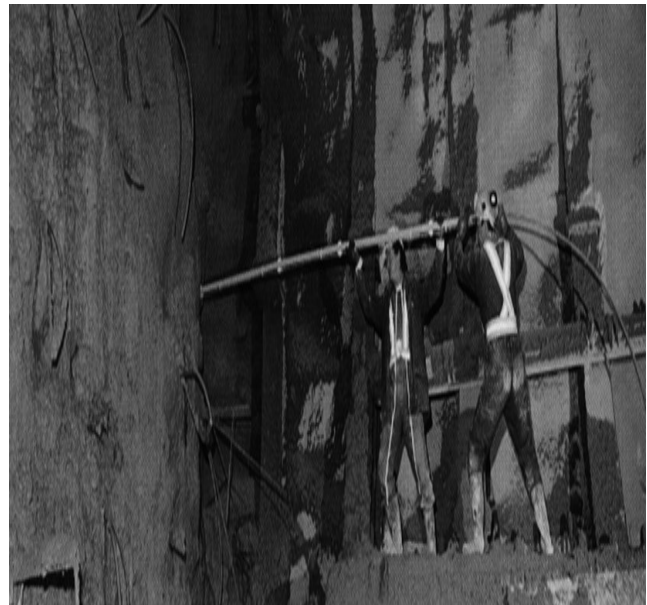
b) Mise en place dans le forage
