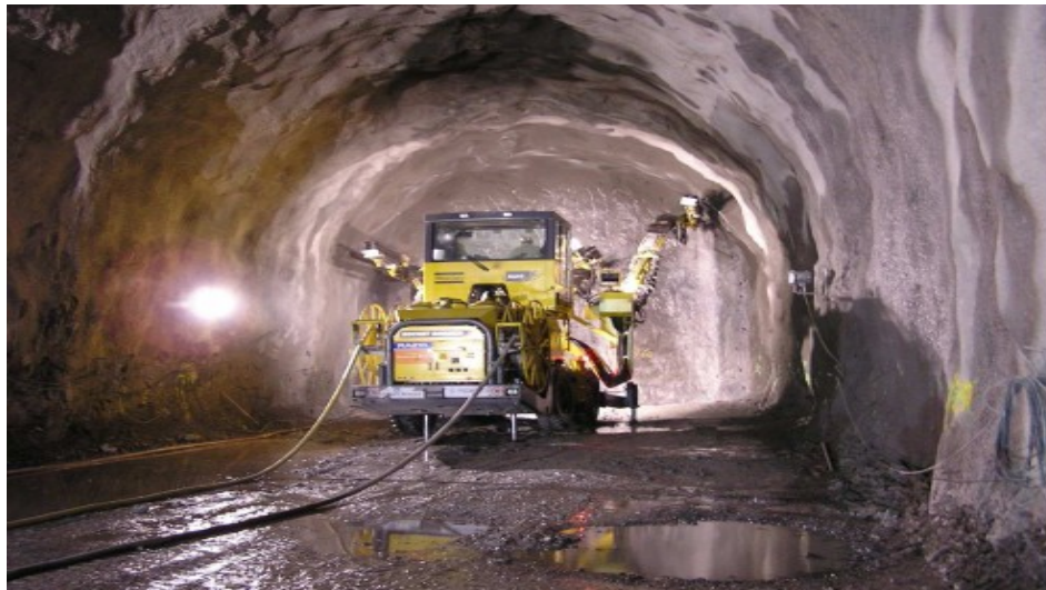
Figure.1.3 La perforation de plan de tir
