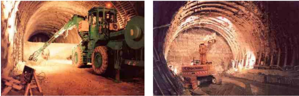
Figure.1.5 Creusement en pleine et demi section
