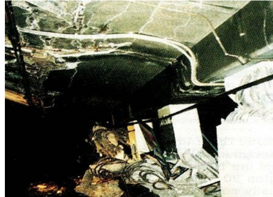
Figure.3.1 Effondrement de la route nationale au-dessus de station de métro de Daikai endommagée par un tremblement de terre (Japon, 1995)
