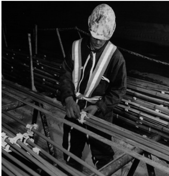
a) Assemblage de boulons
