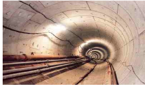
Figure.1.22 voussoirs universels
