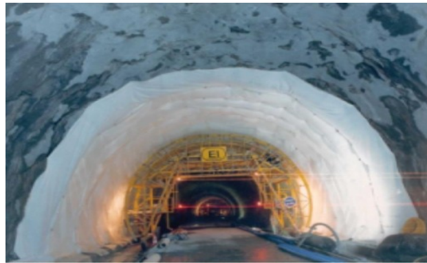
Figure.1.23 Etanchéité d'un tunnel
