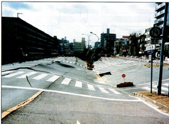
Figure.3.1 Effondrement de la route nationale au-dessus de station de métro de Daikai endommagée par un tremblement de terre (Japon, 1995)
