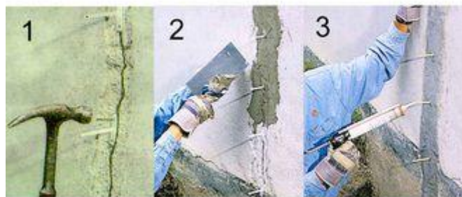
Figure III.5 : la réparation d'une fissure à l'aide d'une injection
