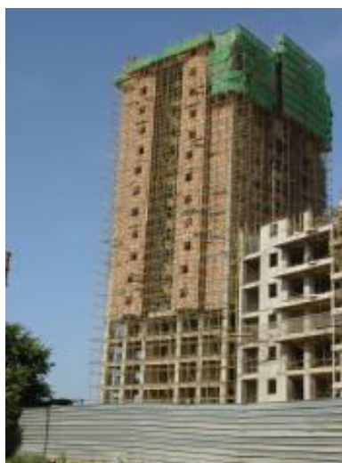
Figure VI-64 : Bâtiment avec voiles en BA, très bonne résistance à l'action sismique.
