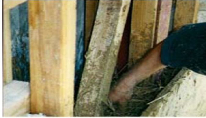
Figure II.20 : Un mélange « terre-paille », en remplissage d'une ossature bois.
