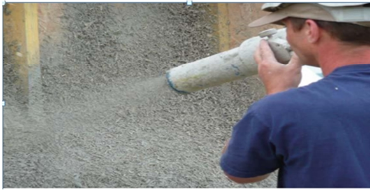
Figure II.7 : Projection mécanique par machine sur une banche
