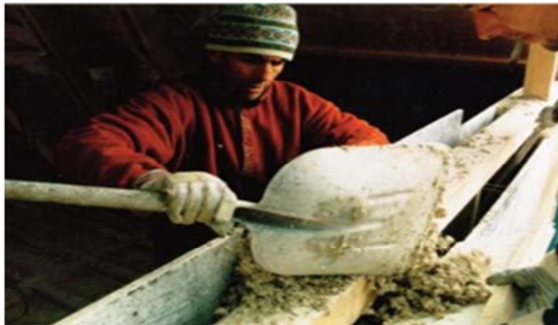
Figure II.8 : déversement manuel entre deux banches
