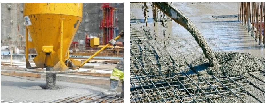
Figure III.23 : Exemples de mise en œuvre des BAP
