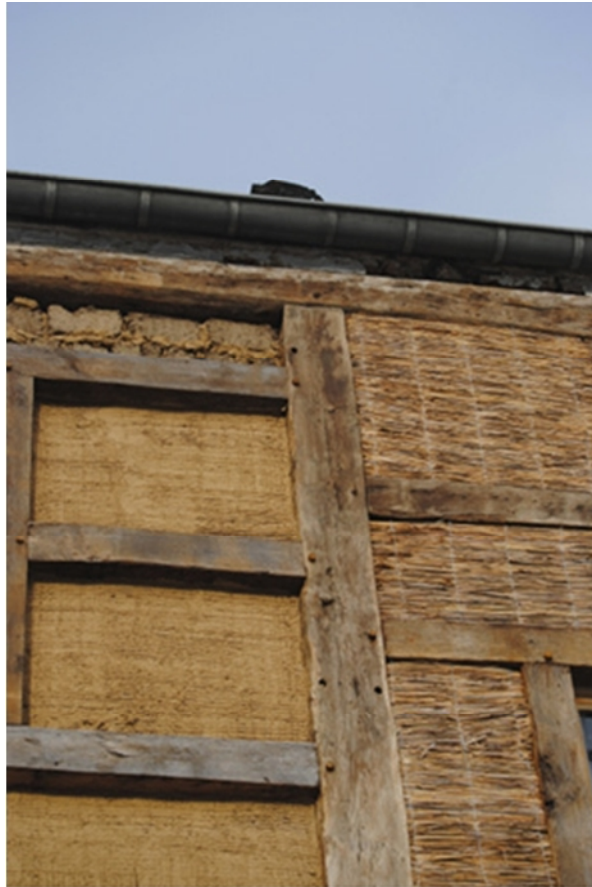
Figure II.19: Façade en restauration en colombage et torchis
