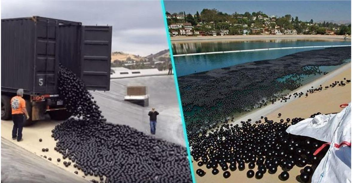
2.17 : Photo des balles en polyéthylène relâchées dans le barrage de Californie afin de minimiser les quantités d'eau évaporées
