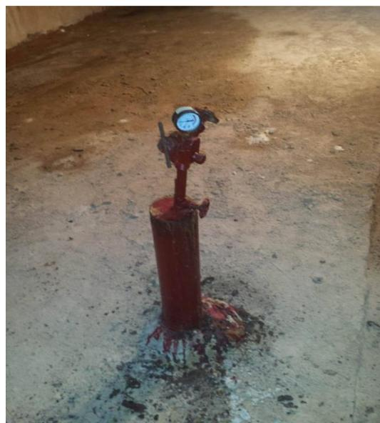
Fig.4.3 : Photo d'un drain (PON) à manomètre dans la galerie du barrage de Zit El Emba.
