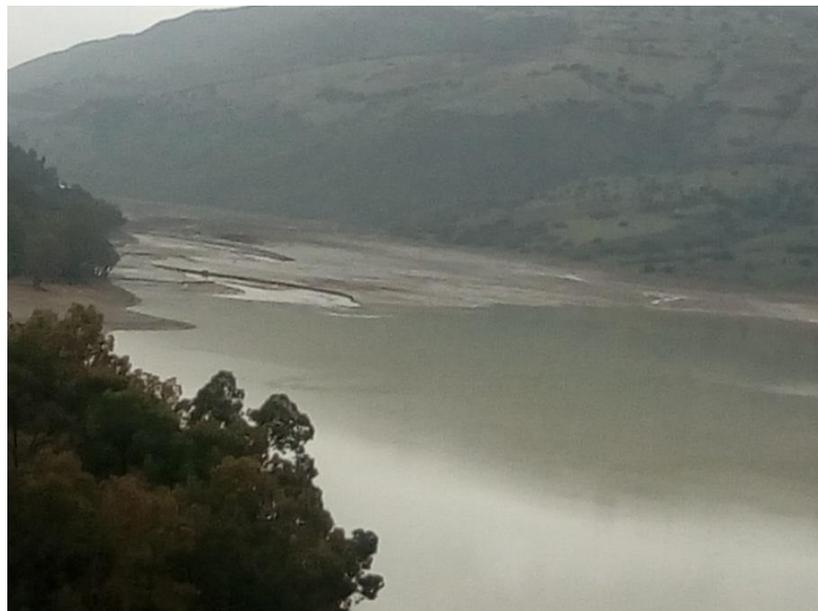
Fig.3.12 : Photo élucide l'état dramatique vis-à-vis la vase dans la cuvette, du barrage de Zardezas (TOUMI, Janvier 2017)
