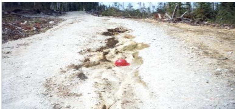
*Figure 20 : Érosion longitudinale de la surface de roulement*
