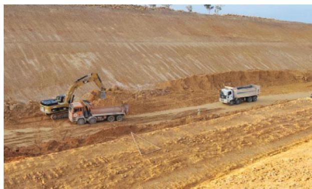
*Figure 1 : Réalisation des travaux de terrassement*
