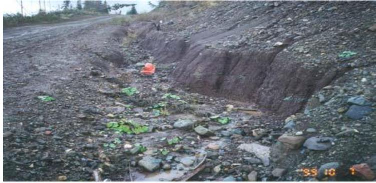
*Figure 21 : Erosion du talus de déblai*
