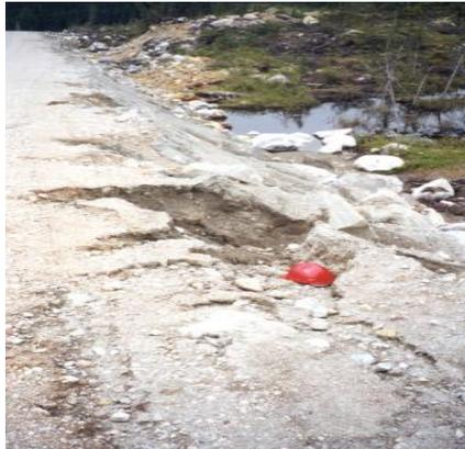
*Figure 22 : Erosion du talus de remblai*
