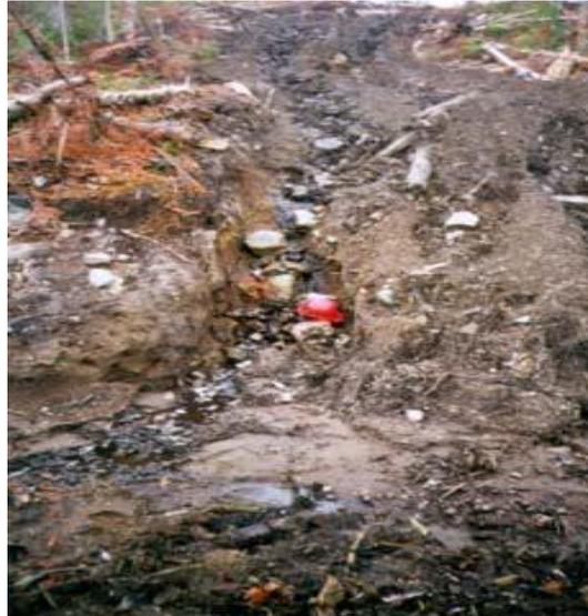
*Figure 23: Erosion du parterre du remblai*
