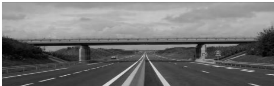
Figure II.56 : Tabliers à trois travées.
