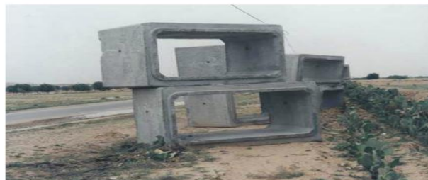
Figure II.6 : dalot préfabriqué près pour être installés.
