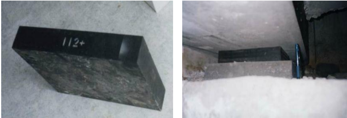
Figure II.18 : Appareil d'appui en élastomère fretté et Appareil d'appui sous une poutre.
