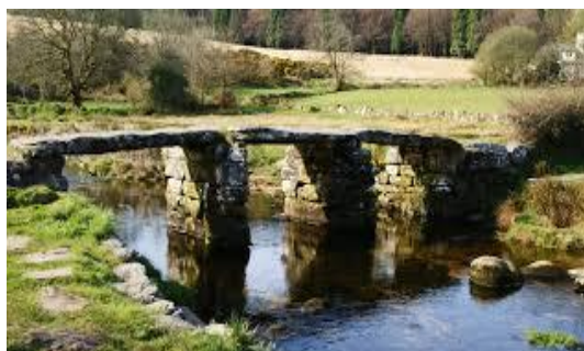
Figure II.25 : Les ponts en dalle.
