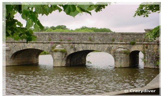
Figure II.26: Les ponts en voûte.
