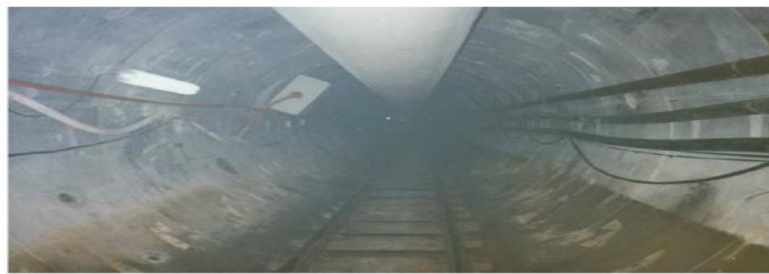
Figure II.9 : vu à l'intérieur du tunnel.
