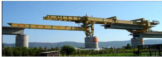
Figure II.32 : Pont en poutre-caisson.
