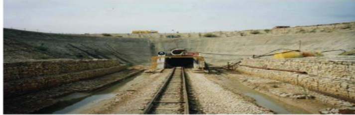
Figure II.8 : entrée du tunnel au cours de construction.
