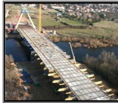
Ouvrages d'arts ponts (tabliers)
