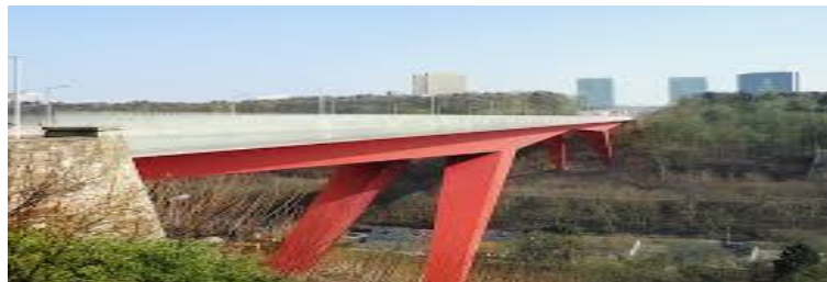
Figure II.36 : Pont grande-duchesse charlotte (luxembourg1965) longueur 335m, houteur47m, portée principale234m.
