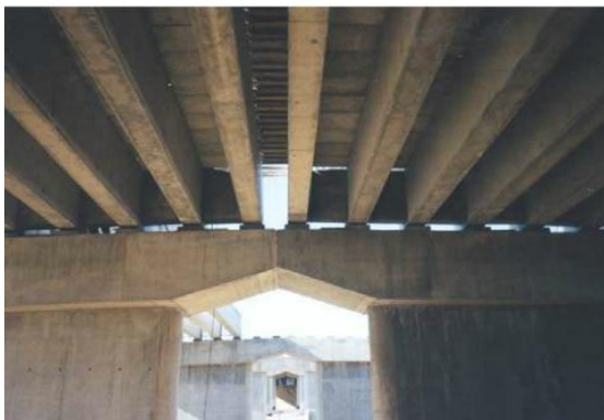
Figure II.21 : vue de dessous d'un tablier et section transversale D'un pont à poutres.
