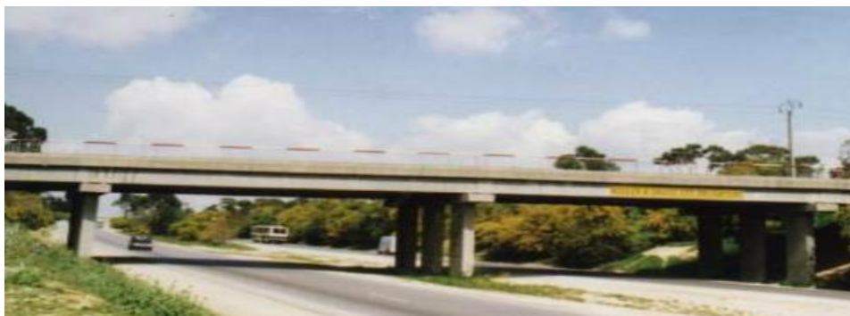
Figure II.14 : pont sur l'autoroute.
