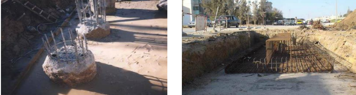
Figure II.15 : Tête des pieux en cours de recépage et Fondations superficielles du pont.
