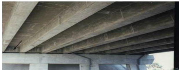
Figure II.17 : Tablier d'un pont a poutre.
