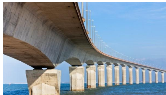
Figure II.30 : Les ponts en poutre à voussoir.
