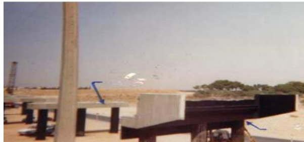
Figure II.16 : appuis du pont.
