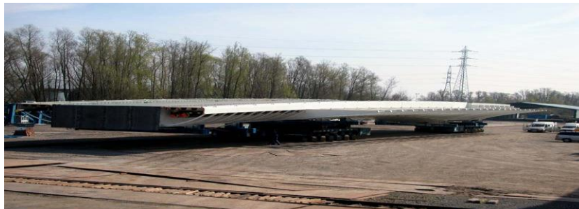
Figure II.50 : Ouvrages à deux caissons.
