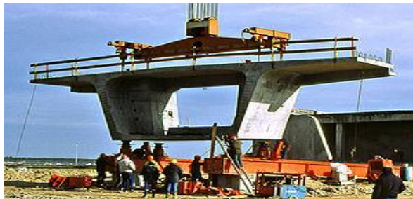
Figure II.43 : forme de ponts caisson.
