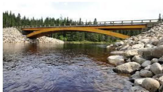
Figure II.24 : Pont à béquilles.
