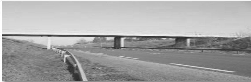
Figure II.57 : Tabliers à quatre travées
