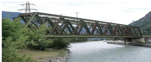
Figure II.33 : Pont poutre en treillis.
