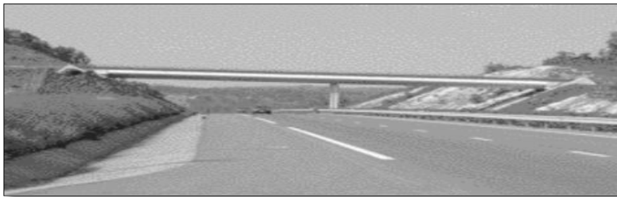
Figure II.55 : Tabliers à deux travées.
