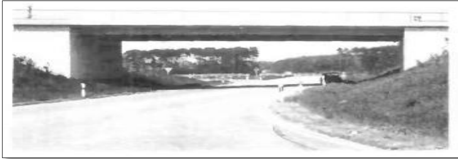
Figure II.54 : Travée unique sur culées massives.
