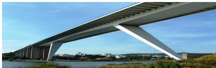
Figure II.37 : virucide Martigues (france1972) longueur 300m, portée principale 130m.
