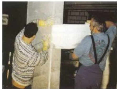
(c) Enchemisement avec PRF in-situ.
