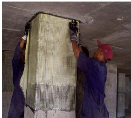
(c) Enchemisement avec PRF in-situ.
