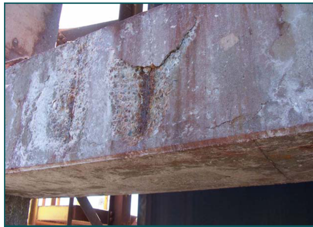
Figure I.3. Délaminage [CRO-07].
