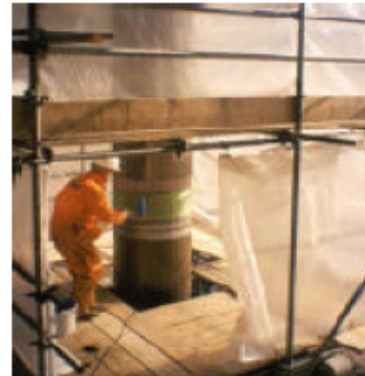
(b) stratification directe en Kevlar
