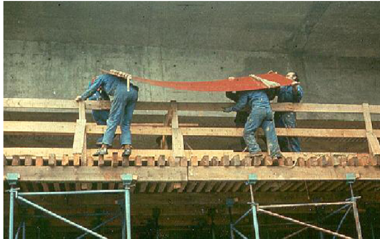
Figure I.7. Difficulté de la mise en œuvre d'une plaque en acier [BEN-09].
