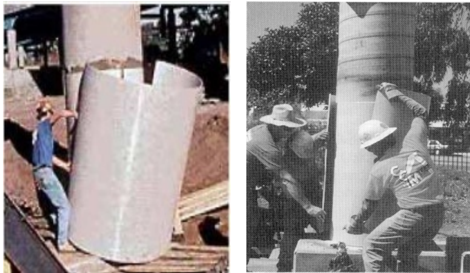
Figure I.22. Enchemisement avec PRF préfabriqué [GIO-03].
