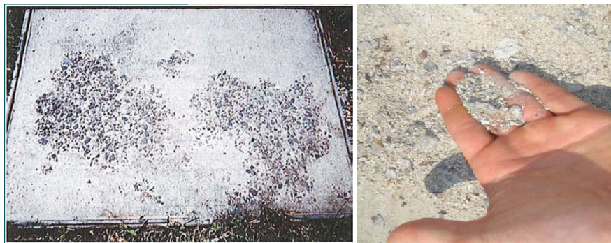
Figure I.1. Écaillage du béton [CRO-07].
