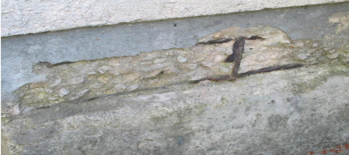
*Figure 2.14 : Pathologie: Eclatement du béton en façade*
