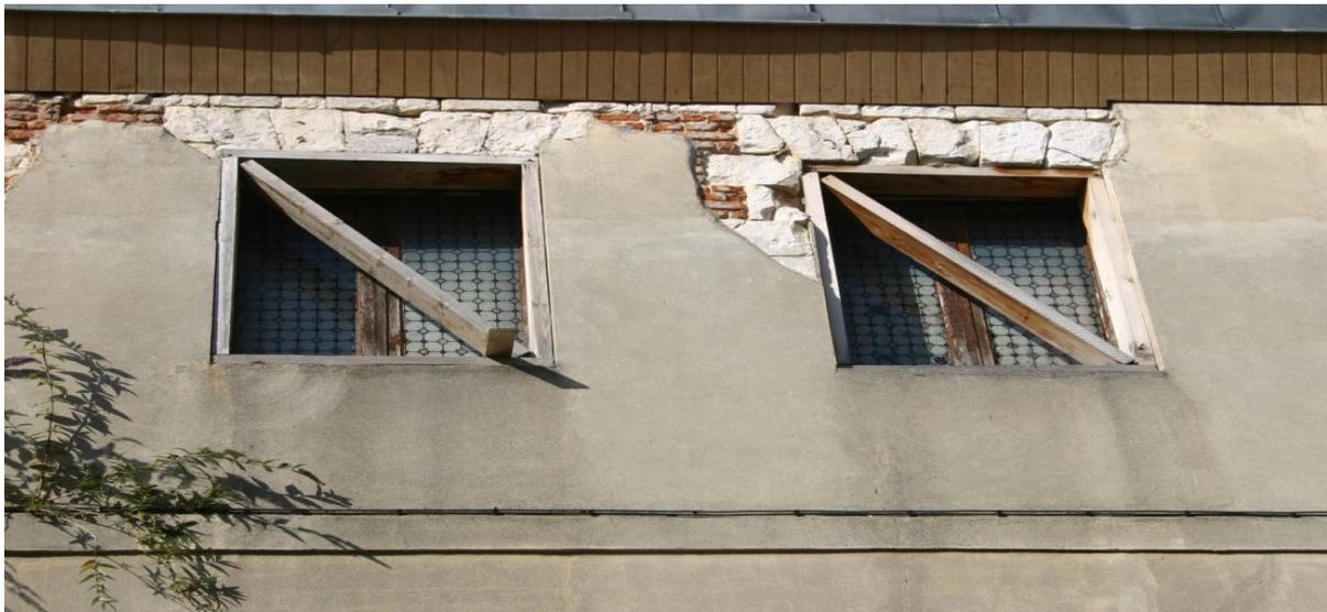
*Figure 2.13 : Pathologie: Affaissement des linteaux*
