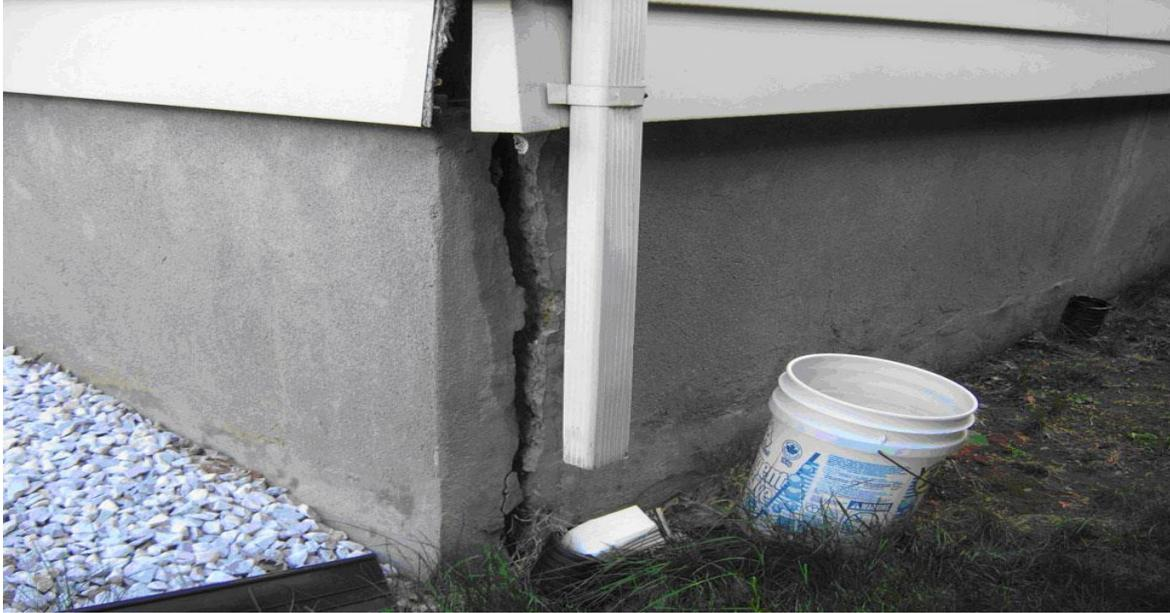
**Figure 2.22 :** Pathologie: Fissuration importante de l'angle du mur de soubassement
