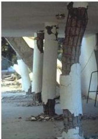
*Figure 2.3: poteaux de géométrie élancée a subi une flexion globale*
