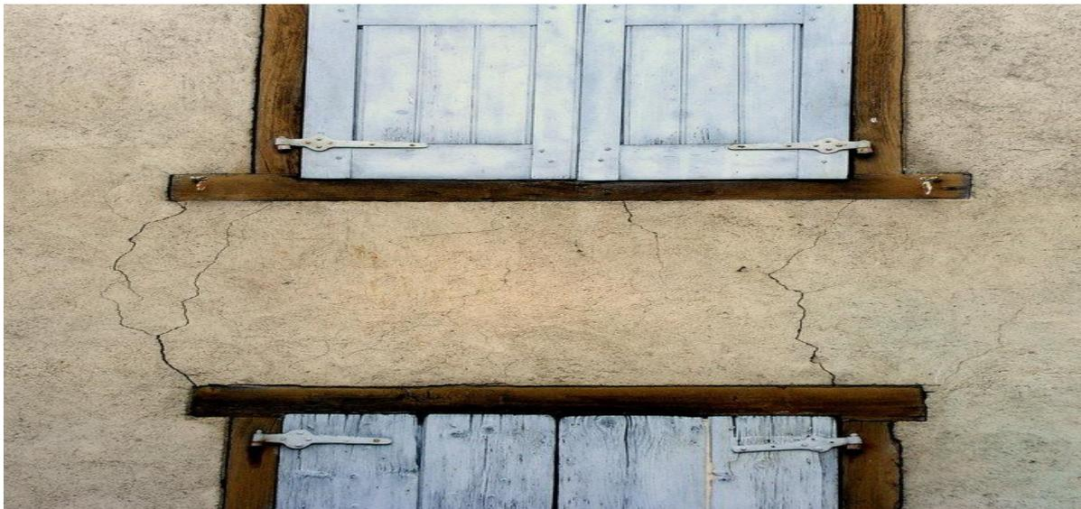
*Figure 2.17 : Pathologie: Fissures en moustache*
