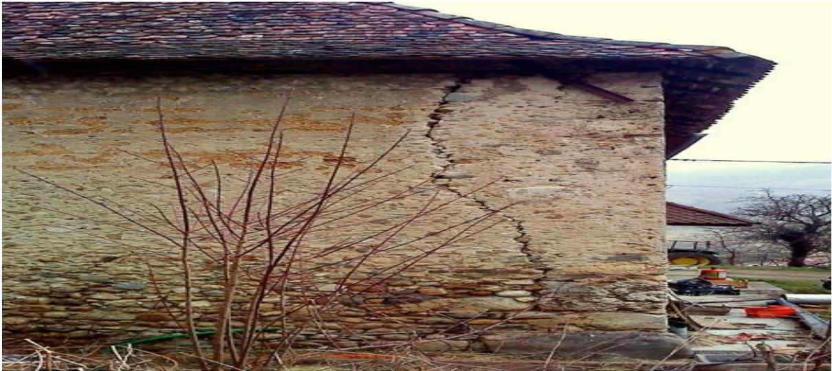
*Figure 2.18 : Pathologie : Fissure d'angle*
