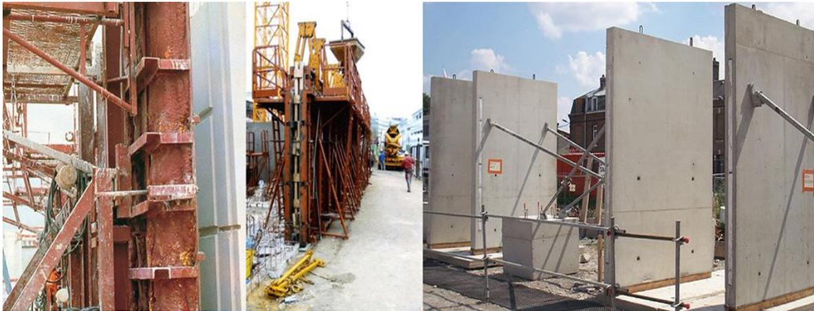
*Figure 3.7 : Construction de voiles en béton armé*
