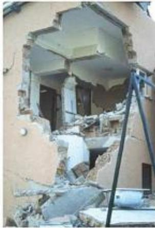
*Figure 2.1 : maçonnerie non chaînée*
