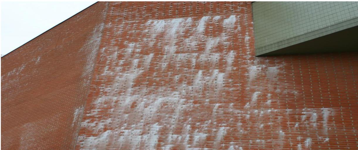
*Figure 2.19 : Pathologie: Apparition de sels sur un mur en terre cuite*
