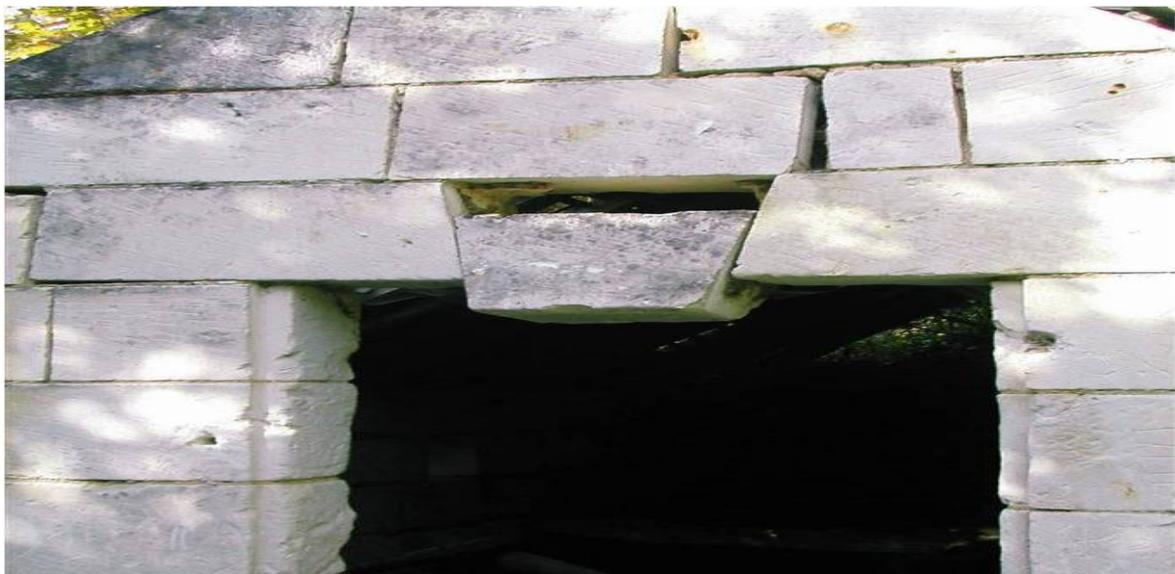
*Figure 2.15: Pathologie: Affaissement de la clé*
