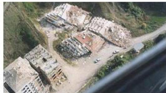
**Figure 2.6 :** effondrement par manque de ductilité
