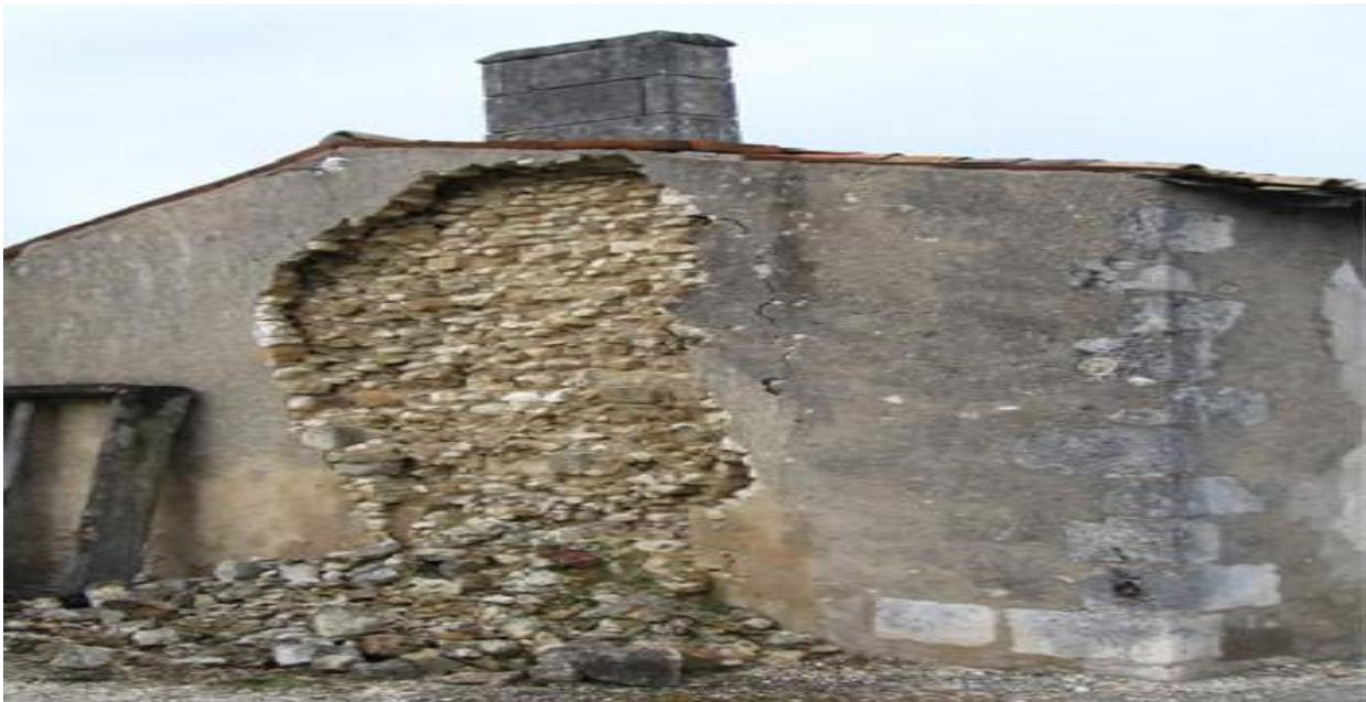
*Figure 2.21 : Pathologie : Désolidarisation des parements*
