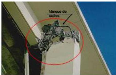
**Figure 2.5 :** éclatement des nœud par manque de frettage
