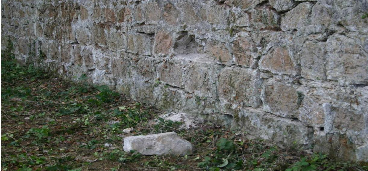
*Figure 2.20 : Pathologie: Chute d'une pierre d'un mur de soutènement*
