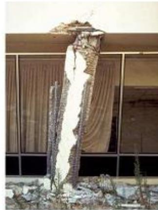
*Figure 2.4 : disposition incorrecte des cadres*
