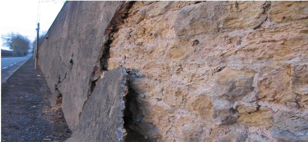
*Figure 2.12 : Pathologie: Décollement de l'enduit sur un mur de soutènement*
