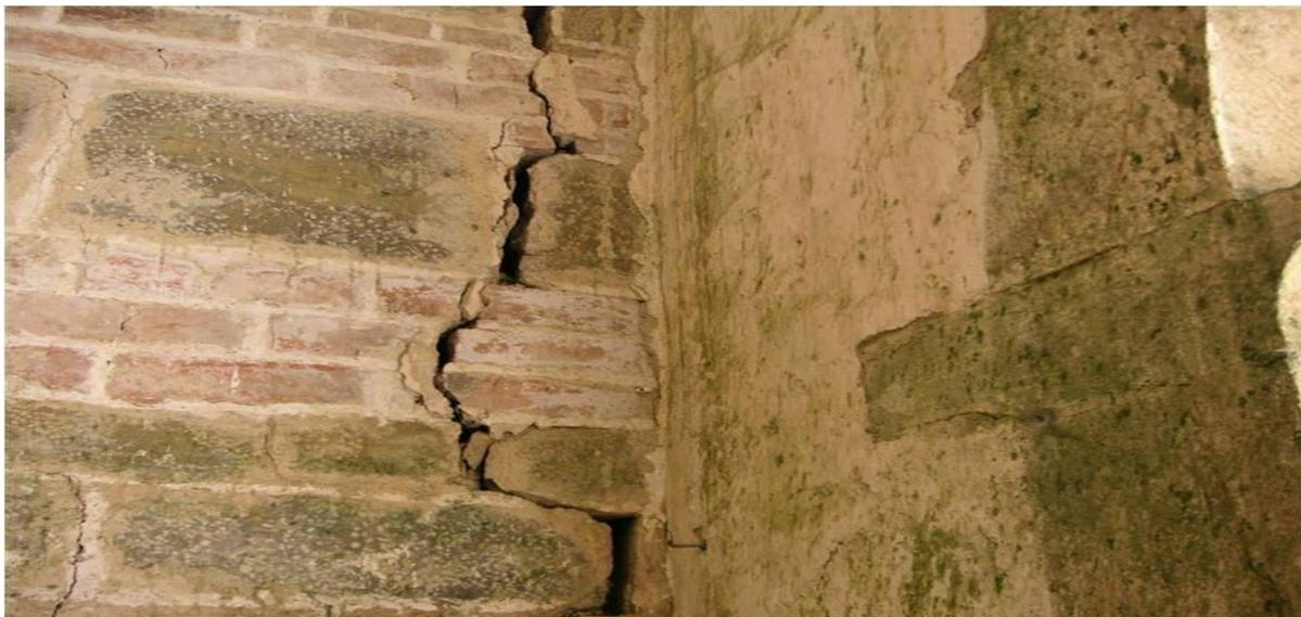
*Figure 2.11 : Pathologie: Désolidarisation d'un mur de refend avec un mur périphérique*
