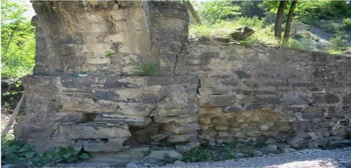
*Figure 2.16 : Pathologie: Déchaussement d'un mur en pierre et fissure entre le mur et l'arche*
