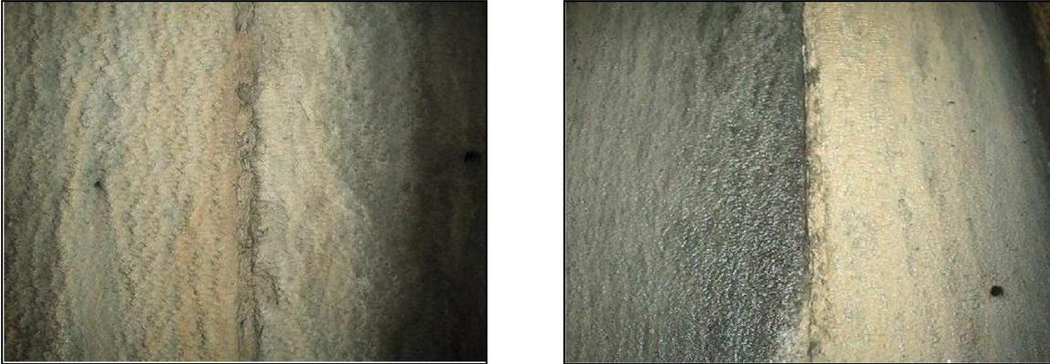
**Figure II.1:** Exemple de stalactites blanchâtres en surface du béton.
