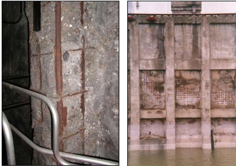
**Figure II.5:** Exemple de corrosion ayant entraîné décollements du béton.
