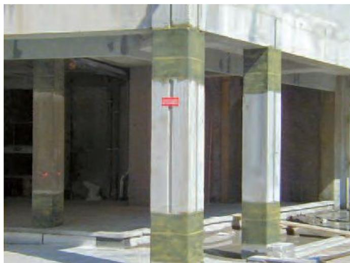
**Figure IV.16:** Freinage de poteaux par composites.
