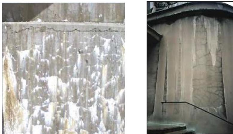
**Figure II.2:** Exemple de faïençage lié à une attaque sulfatique.
