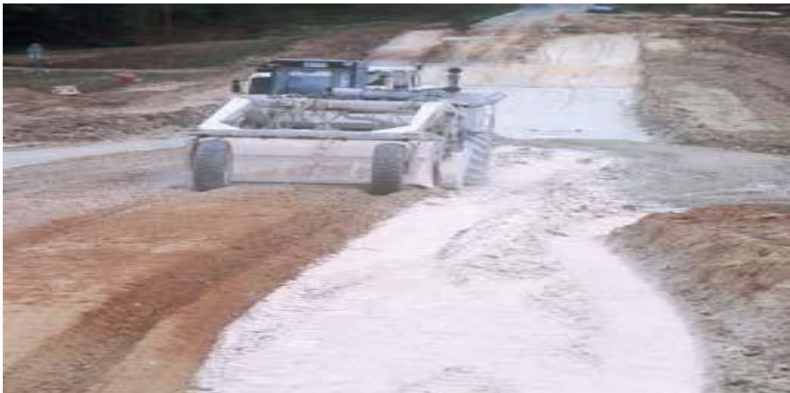
Fig III-6 : Malaxage d'un sol traité aux liants hydrauliques revue de l'école des ponts et chaussées Paris 2010
