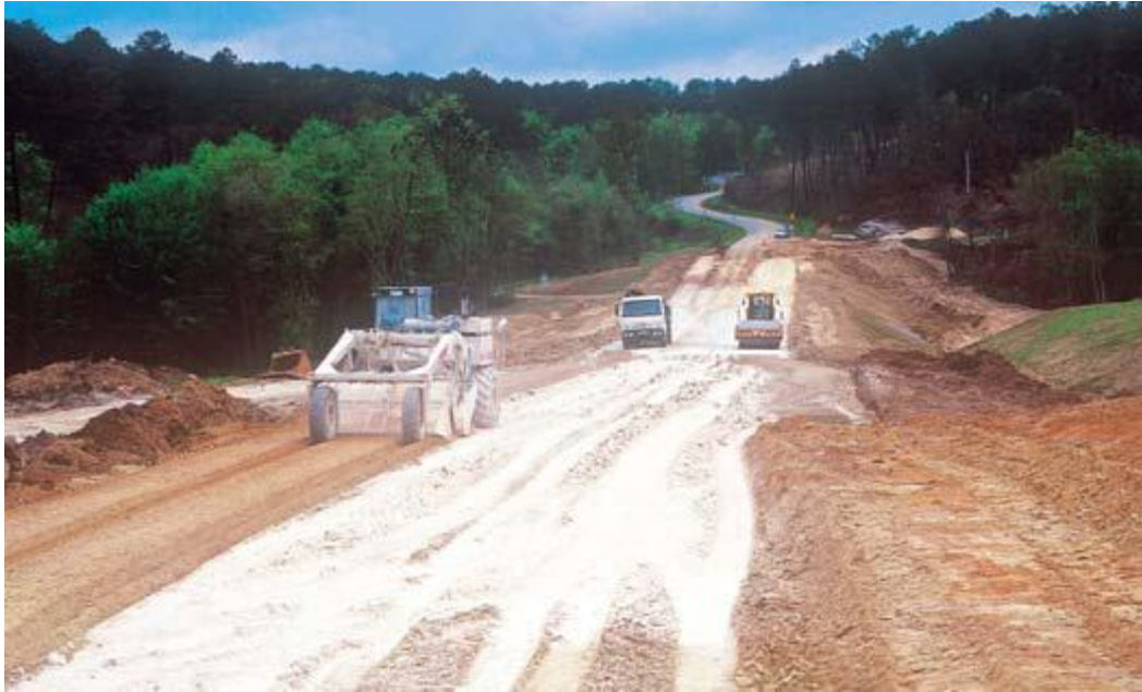
Fig III-1 : sol traité à la chaux « revue de l'école des pont et chaussé Paris 2010 »
