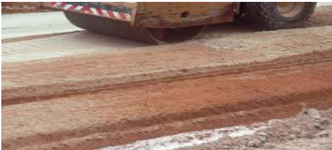
Fig III-4 : Compactage d'un sol traité à la chaux revue de l'école des ponts et chaussées Paris 2010
