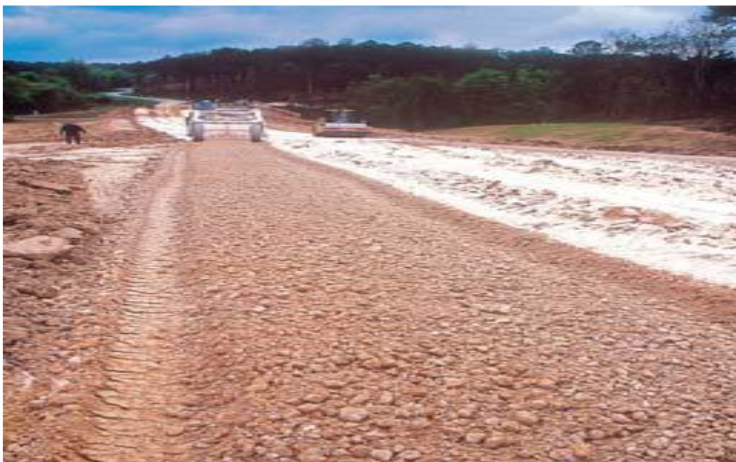
Fig III-2 : Traitement in situ d'un sol argileux par la chaux revue de l'école des ponts et chaussées Paris 2010
