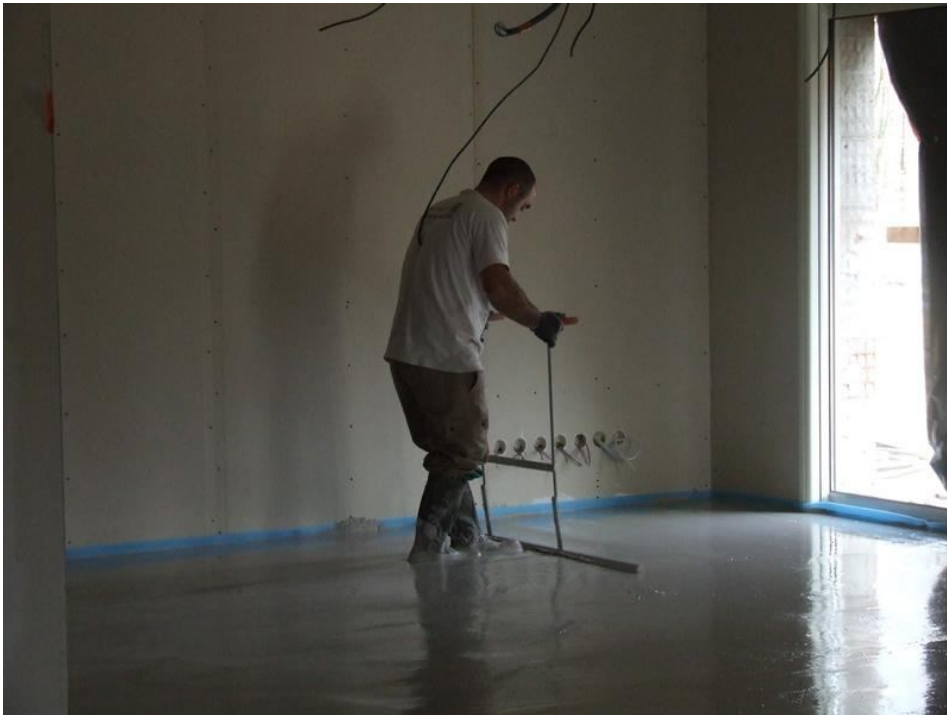
Fig. 1.23 : Réglage d'une chape.
