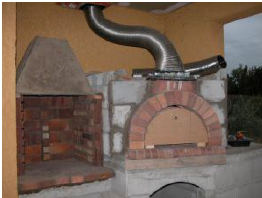
Fig.3.5: Fournil réalisé avec un mortier réfractaire. [37]
