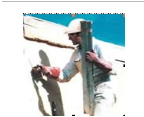
Fig.1.24 : Serrage d'un enduit à la spatule
