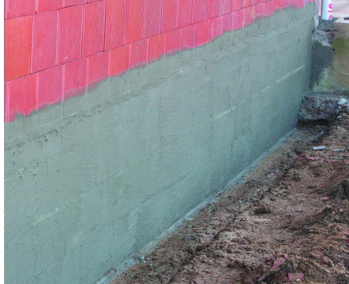
Fig.3.3: Mortier d'enduits imperméabilisants [35]
