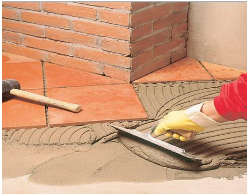
Fig.3.1: Mortiers-colles pour la pose de carrelages.
