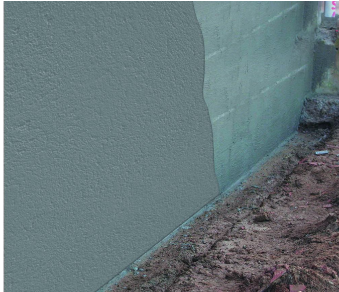
Fig.3.4: Mortier d'imperméabilisation en couche mince [35]
