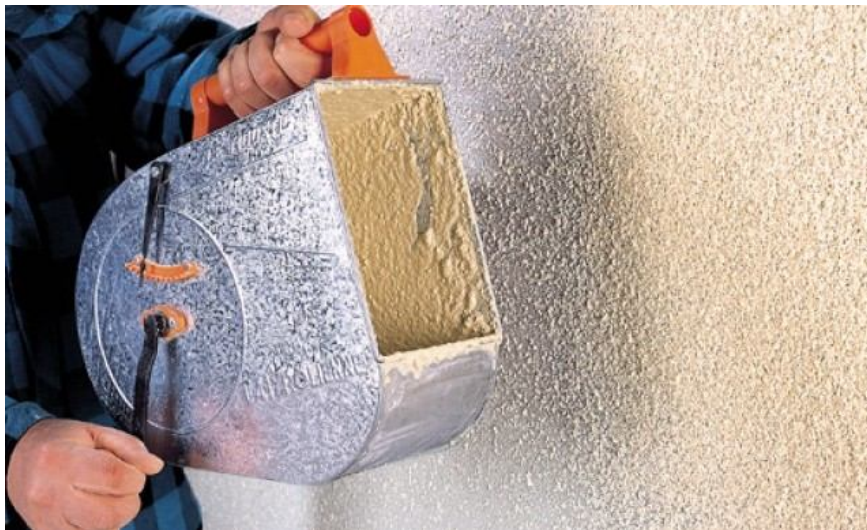
Fig.3.2: Application d'un enduit minéral sur un mur de façade.
