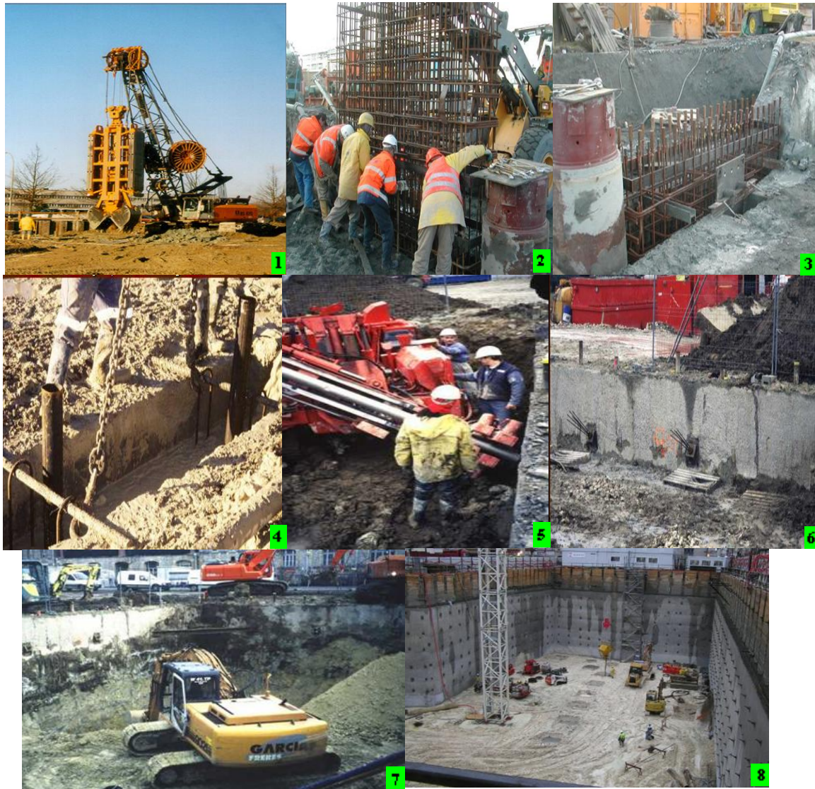
Fig1.2 Phases de construction d'une paroi moulée ancrée [9].
