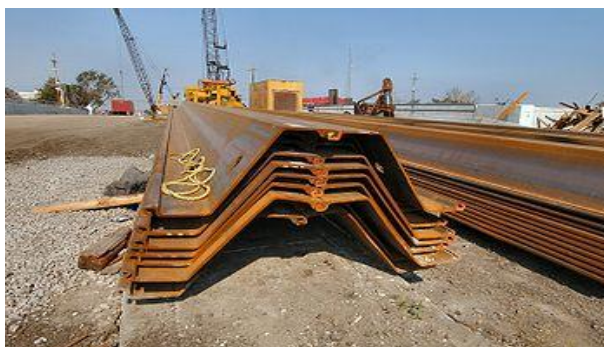
Fig1.3 Palplanches empilées avant battage [9].
