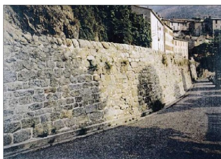
En maçonnerie jointoyée
