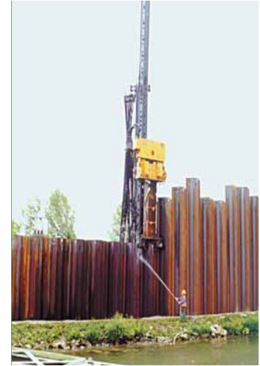
Fonçage par vibration
