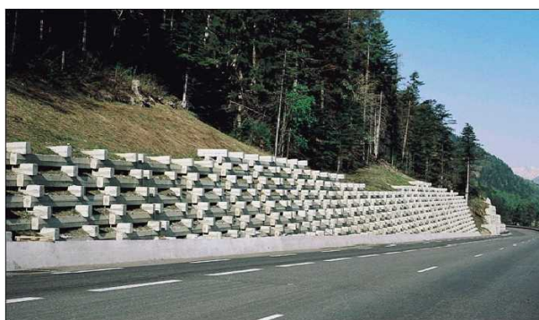
En éléments préfabriqués.
