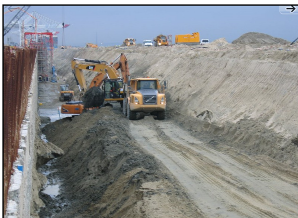
(b) Terrassement devant la paroi moulée pour la réalisation de la poutre de couronnement.
