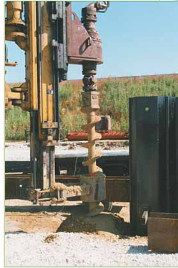
perforage avant fonçage
