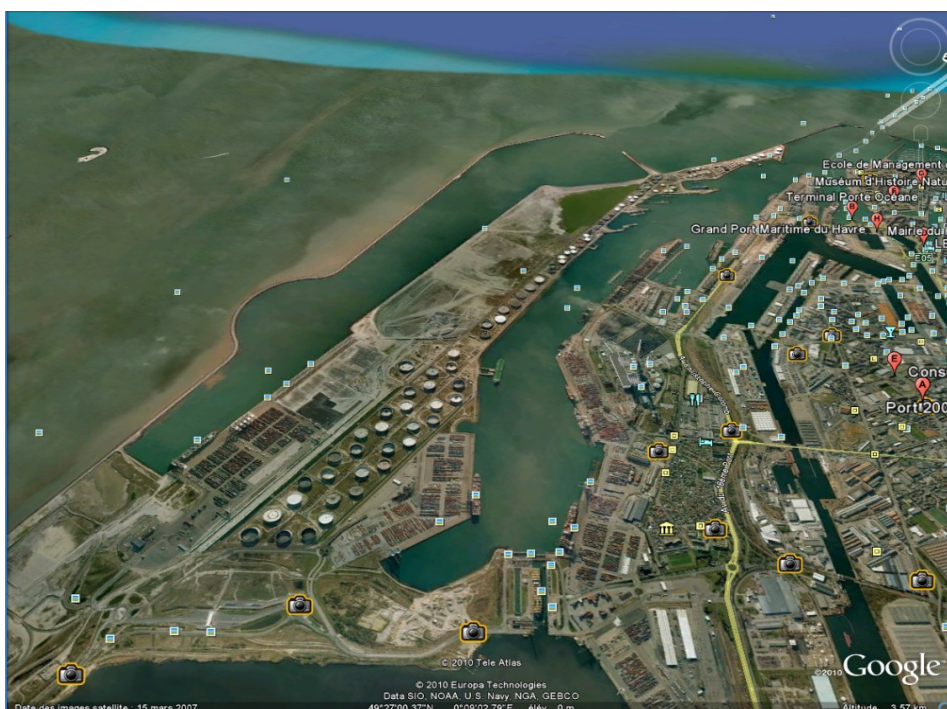
Figure 4.2 : Vue aérienne du quai port 2000 Google earth mars 2007
