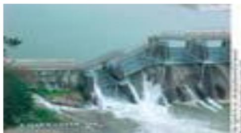
**Figure I.2** Dégâts dans le déversoir de Shih-Kang (Taiwan, 1999)
